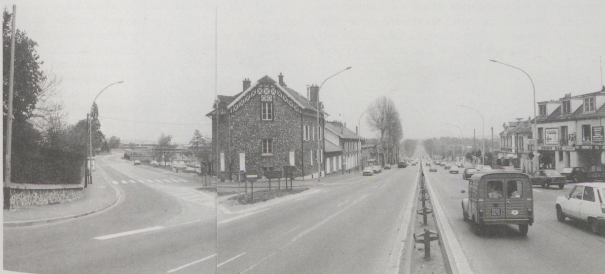
Fig. 7 : La N 184 dans la traversée de Rocquencourt
