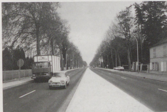
Fig. 4 : La N 184 A à la hauteur du viaduc de la S.N.C.F.
