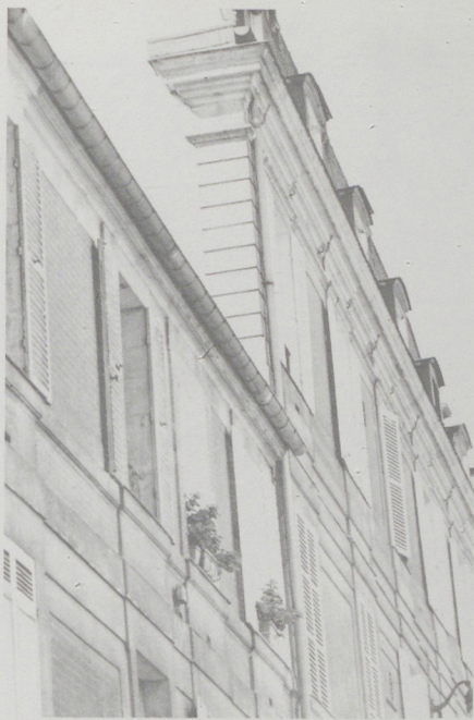
fig. 10 : l'angle révèle l'épaisseur de la façade.
