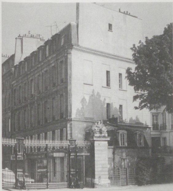
fig. 9 : mur pignon donnant sur le parc du Château de Versailles.
