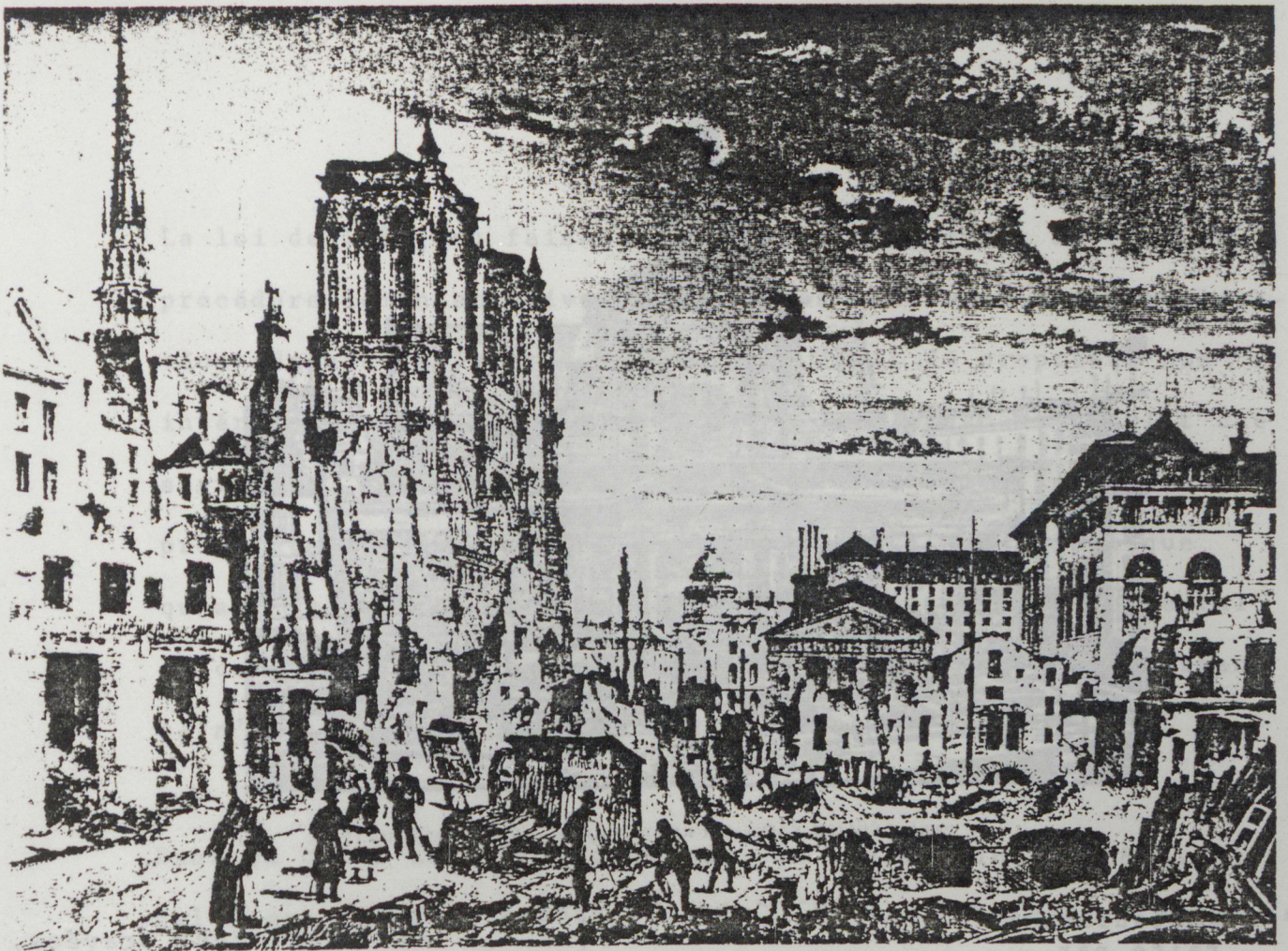
Démolitions autour de Notre-Dame.
