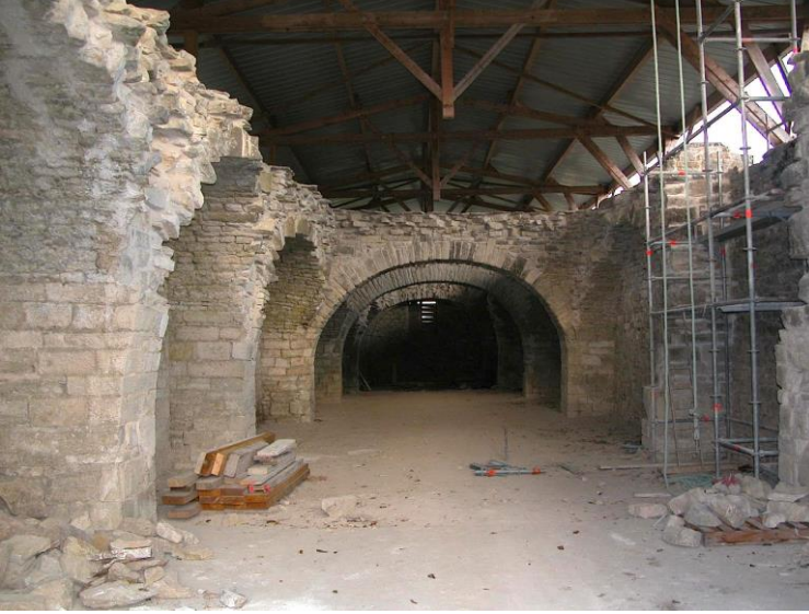
Figure 1 - Vue des caves de l'abbaye Saint-Vivant de Vergy en cours de rénovation - (photo: J.-P. Garcia, novembre 2004)
