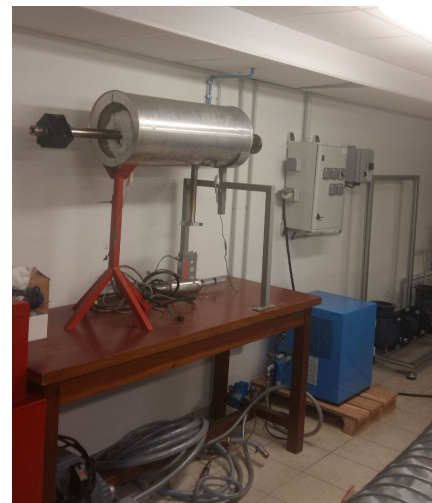
Fig. 11. Différents éléments du système en cours d'assemblage.
