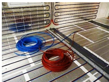
Fig. 2. Installation des panneaux rayonnants sur l'enveloppe
