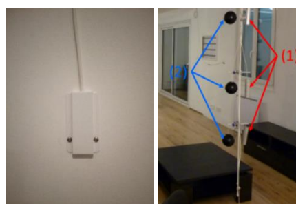
Fig. 5. À gauche : sonde PT100 fixée sur une surface. À droite : mât de mesure de l'ambiance intérieure
