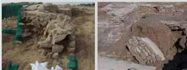
**Action :** bouleverse l'équilibre fragile des structures en terre, et concentre les échanges d'humidité en des points précis.
