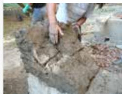
Éléments découpés mis en place à l'état plastique sur l'assise de bauge coffrée
