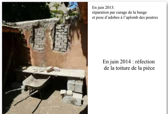
En juin 2013 : réparation par curage de la bauge et pose d'adobes à l'aplomb des poutres
