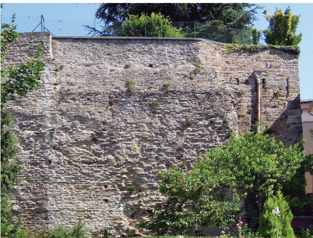
Fig. 11. Mur sud de la «terrasse Cléberg» (É. Bertrand).
