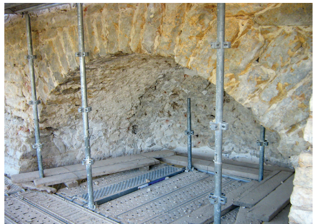
Fig. 13. Voûte en cul-de-four de l'arcade n° 1 chemisée par des maçonneries modernes (E. Bernot).
