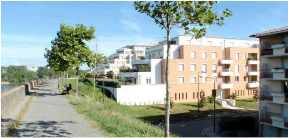
Constructions peu vulnérables adossées à la digue renforcée (Source : notice de présentation du PPRI)
