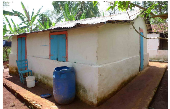
La partie supérieure des murs est moins épaisse que la base.
