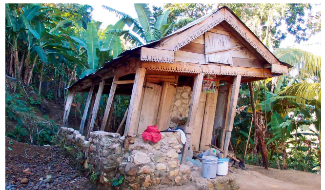
La flexibilité de la structure en bois (avec des bons assemblages) permet d'éviter un effroulement de la structure lors d'un seisme ou d'un cyclone.
