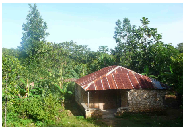
La végétation qui entoure la maison constitue une protection contre les vents.
