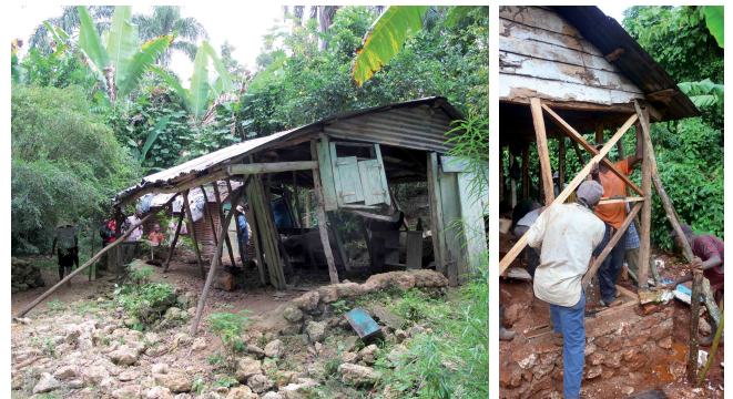
Reconstruction réutilisant les matériaux récupérés.
