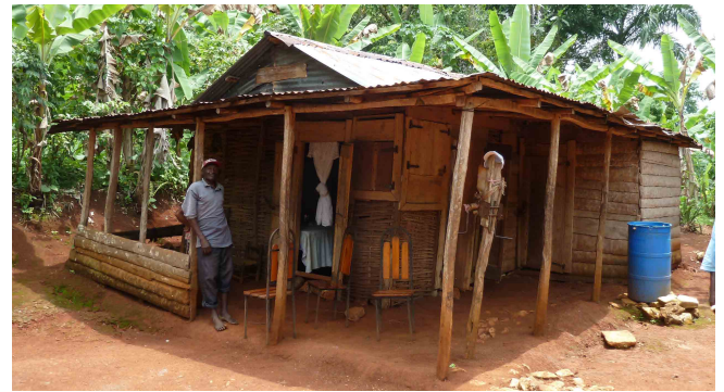
Maison à Carrefour : poteaux plantés dans le sol ; murs en clissage (non enduit) et bardage ( planch ) ; toiture à 2 pans en CGI ; galerie structurellement indépendante de la maison, «effet fusible» de la liaison entre les deux toitures.
