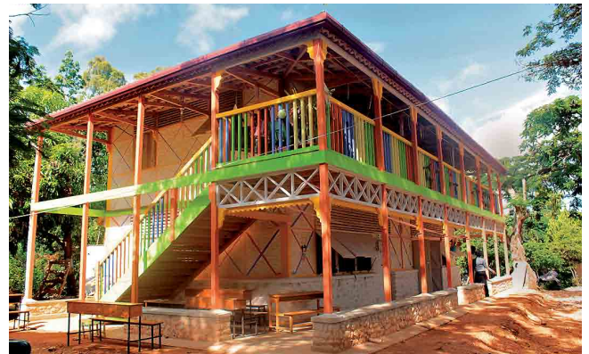
Bâtiment public à étage, réalisé selon les principes de Cultures Constructives Locales améliorées, avec ossature bois et remplissage en maçonnerie de pierre (ti wòch)- École de Grand Boulage, EdM.
