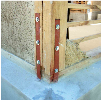
Ancrage de la structure en bois au soubassement, avec des feuillards métalliques (ce système a été introduit par des organisations d'aide, à la suite des catastrophes).
