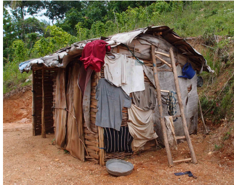
Habitat précaire : Maison en clissage, fibres et matériaux de récupération, à Coupeau, Carrefour.
