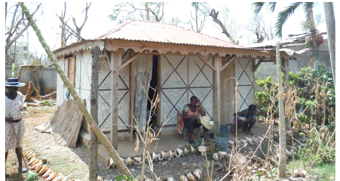
Photo prise juste après le cyclone «Matthew» (octobre 2016). Maison à Dame-Marie (Anse-d'Ainault, Grand'Anse), réalisée avec ossature bois et remplissage en maçonnerie de pierre (ti wòch) et clissage (klisay), en 2013 dans le cadre du «Programme Sandy», FICR.
