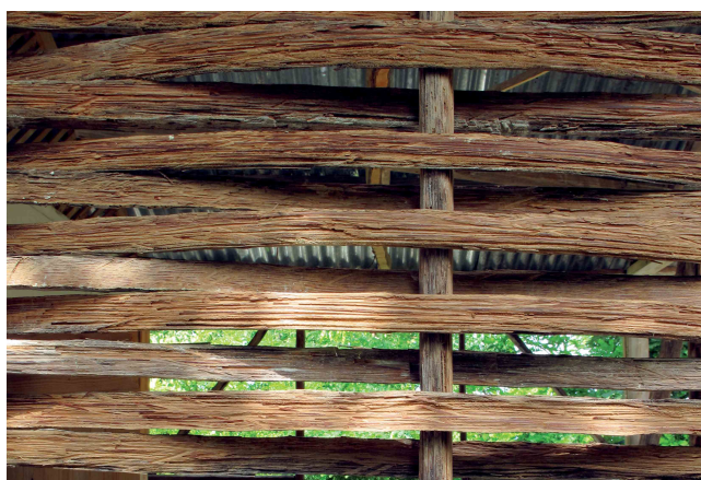
Le lattes pour le clissage est très perméable à l'air, permettant une bonne ventilation. Toutefois, cela n'empêche pas l'entrée d'insectes et autres petits animaux dans la maison.
