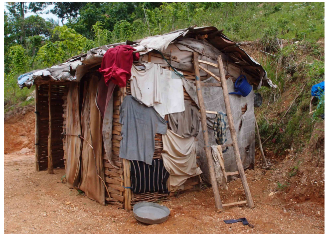
Maison précaire, construite à partir de matériaux locaux et de récupération. Mauvais choix du site d'implantation (contre la colline), risque d'éboulement et de dégâts en cas de fortes pluies.
