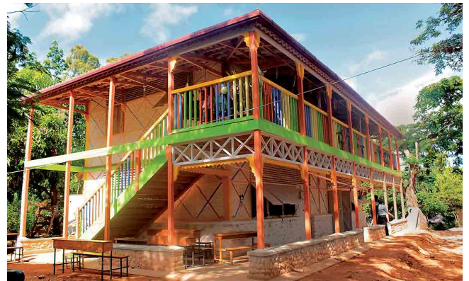
Bâtiment public à étage, réalisé selon les principes de Cultures Constructives Locales améliorées, avec ossature bois et remplissage en maçonnerie de pierre (ti wòch)- École de Grand Boulage, EdM.
