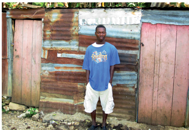
L'utilisation de tôles pour les murs et/ou toiture rend la température très élevée à l'intérieur de la maison.
