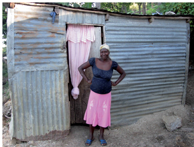
Utilisation de matériaux locaux et/ou de récupération : bois pour la charpente et tôles métalliques pour les murs et toiture.
