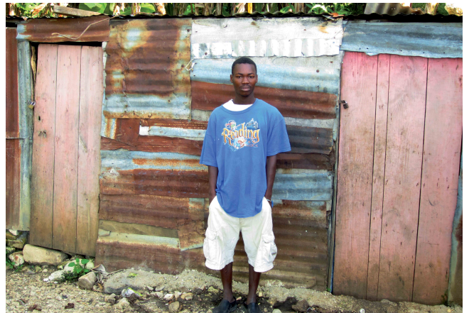
L'utilisation de tôles pour les murs et/ou toiture rend la température très élevée à l'intérieur de la maison.
