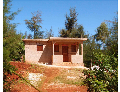
Habitat issu des influences internationales : Maison en béton armé et parpaings, à Salagnac, Miragoane.
