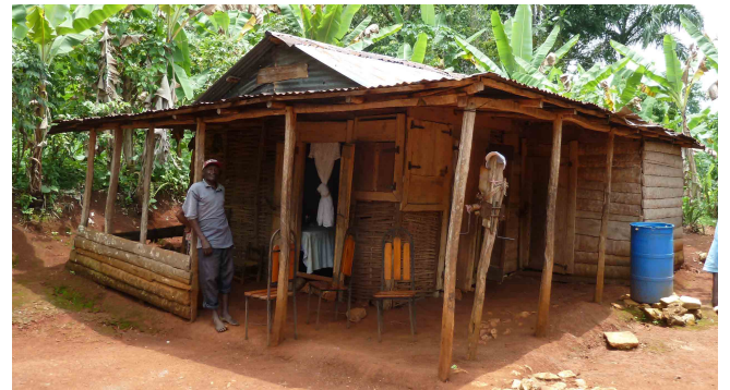
Maison à Carrefour : poteaux plantés dans le sol ; murs en clissage (non enduit) et bardage ( planch ) ; toiture à 2 pans en CGI ; galerie structurellement indépendante de la maison, «effet fusible» de la liaison entre les deux toitures.
