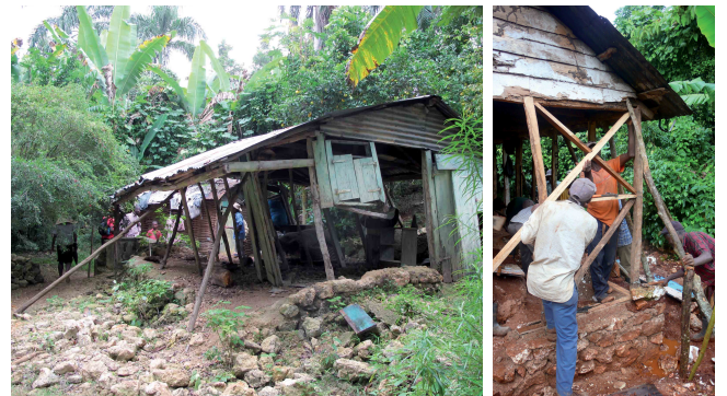
Reconstruction réutilisant les matériaux récupérés.
