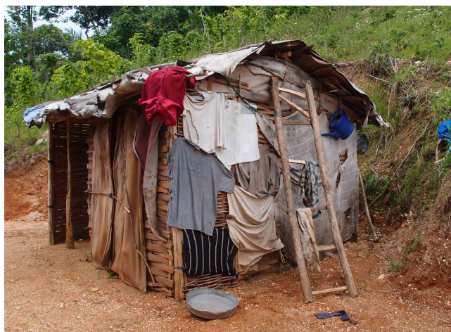
Maison précaire, construite à partir de matériaux locaux et de récupération. Mauvais choix du site d'implantation (contre la colline), risque d'éboulement et de dégâts en cas de fortes pluies.
