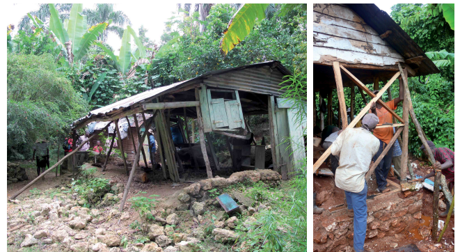
Reconstruction réutilisant les matériaux récupérés.
