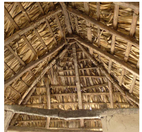
Différents types de toitures en fibres permettant une très bonne ventilation. Existents : en vétiver à 4 pans (gauche); en fibres de palmier à 2 pans (centre); en fibres de palmier à 4 pans (droite).
