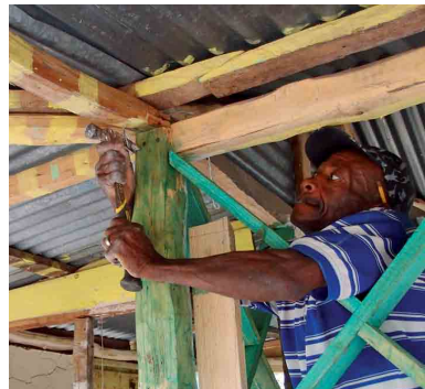
Ancrage de la charpente à la structure en bois, avec du fil de fer torsadé (système plus accessible que les feuillards métalliques).
