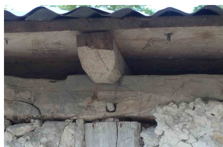
Assemblages traditionnels d'éléments en bois : tenon-mortaise avec cheville, liaison à tiers bois.
