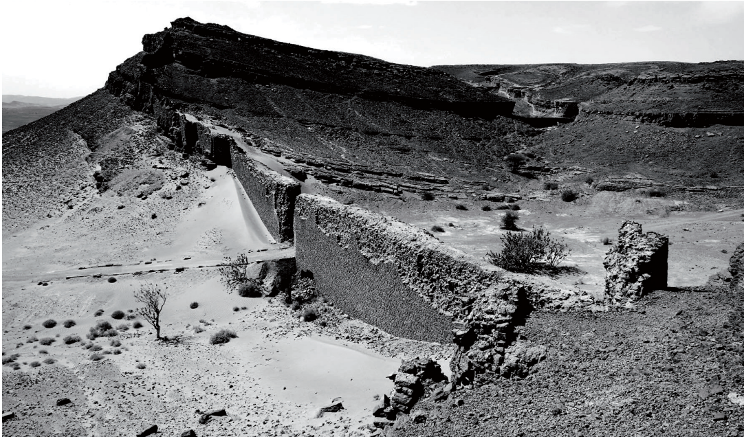
Figure 3 : vue d'ensemble de la muraille basse, de la courtine sud-est (au premier plan) et de la courtine ouest (à l'arrière plan à gauche) montant à l'assaut des falaises du Jebel Mudawwar. Au centre de l'image : la rampe d'accès en béton abandonnée par les équipes du film La Momie . A l'arrière plan à droite, l'un des quatre barrages construit dans une des principales ravines du site.
