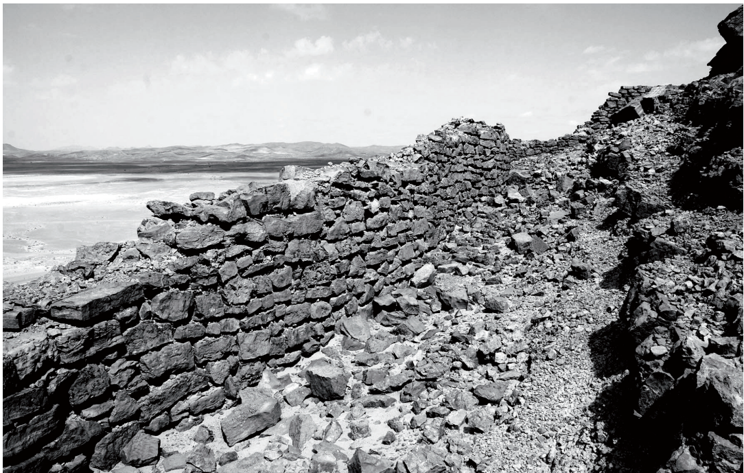
Figure 4 : chemin de ronde parcourant le pourtour sud-ouest du Jebel Mudawwar le long de la muraille : à l'arrière plan se déploie le paysage plan du Tafilalt en direction de l'ouest avec, sur la ligne d'horizon, les derniers contreforts de l'Anti-Atlas et le col du Tizi u-Mkhazni.
