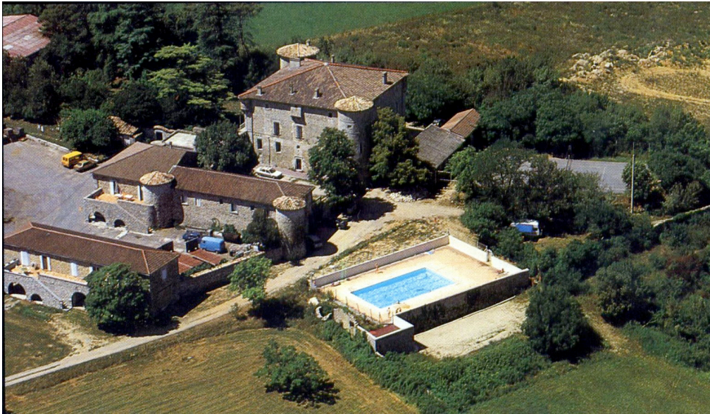
Fig. 1 Vue aérienne, façade est.
