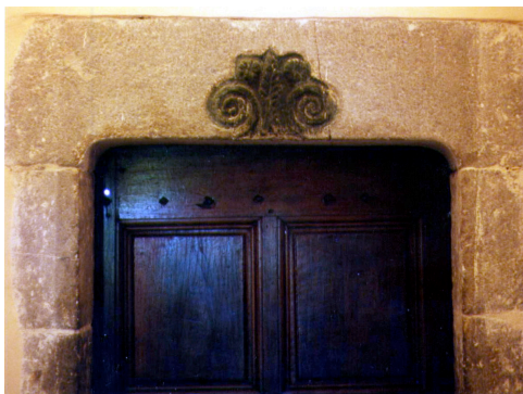
Fig. 15 Linteau de la porte de la salle d'apparat.
