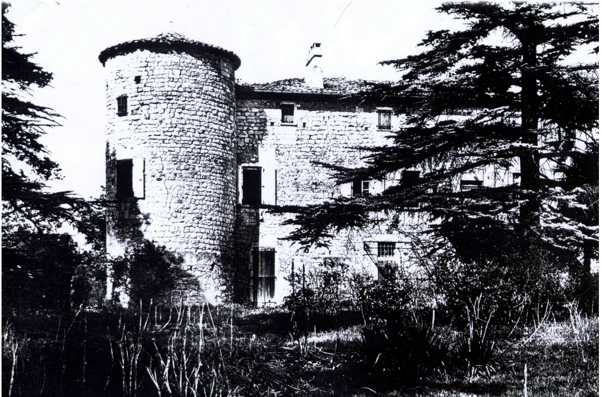
Fig. 6 Façade sud avant les travaux de construction du balcon.
