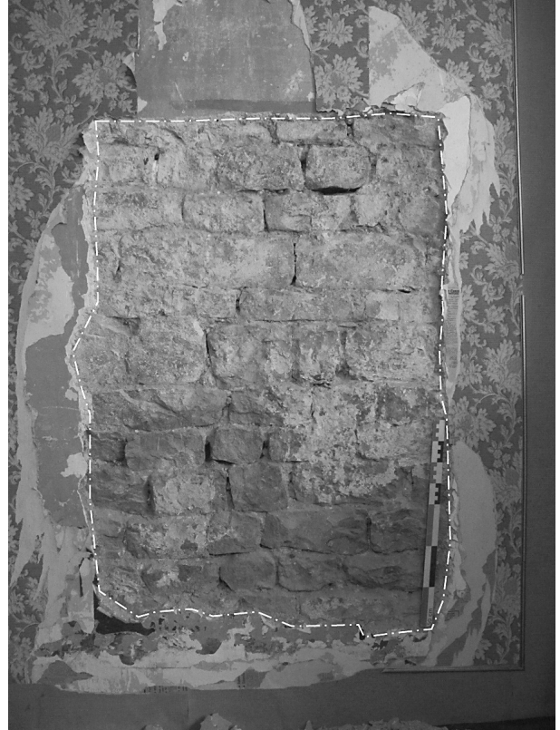
Fig. 21 : Vue du parement mis au jour dans un des sondages du premier étage (Photographie R. Pellé).
