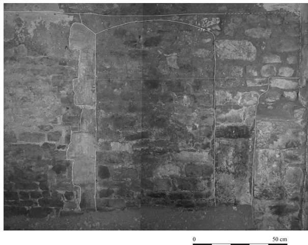
Fig. 5 : Vue du piédroit de la porte du rez-de-chaussée du deuxième état (Photographie R. Pellé).
