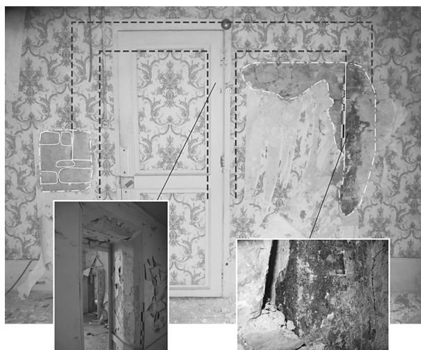
Fig. 15 : Vues de la fenêtre à meneau occidentale de la pièce construite sur le porche (Photographies R. Pellé et M. Rochette).
