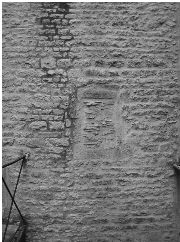
Fig. 4 : Détail de la maçonnerie de la façade (Photographie M. Rochette).
