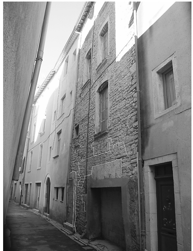
Fig. 18 : Vue de l'accès au sud par le rue du Bât d'Argent. Le linteau monolithe est conservé au-dessus du portail actuel (Photographie R. Pellé).
