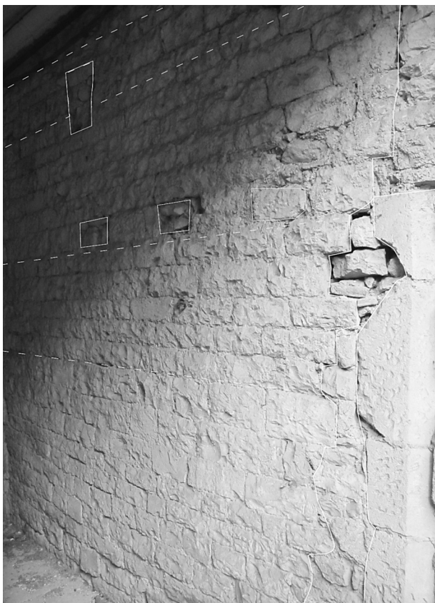
Fig. 13 : Vue du mur de façade au premier étage. On observe la qualité du parement et l'emplacement de deux larges bandes de peinture rouge. (Photographie R. Pellé).
