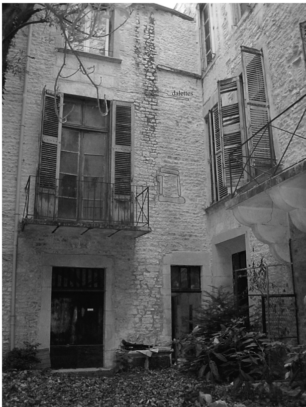
Fig. 3 : Vue de la façade au nord du jardin, avec à l'est le petit appareil du XIII e siècle (Photographie M. Rochette).
