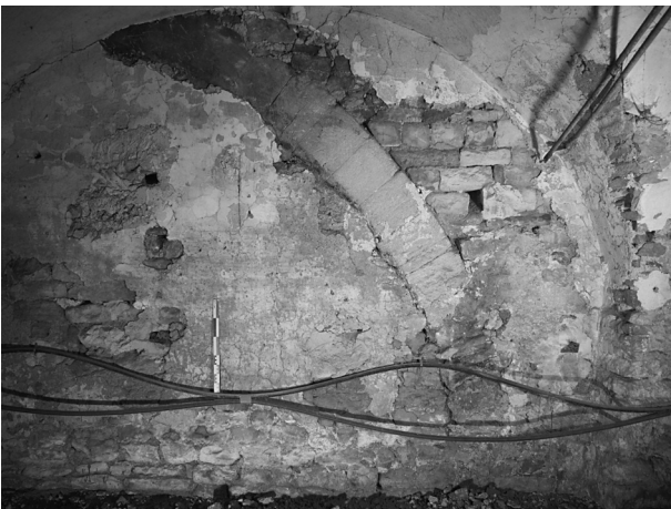
Fig. 20 : Vue de l'arc ouvrant sur un bâtiment oriental (Photographie R. Pellé).
