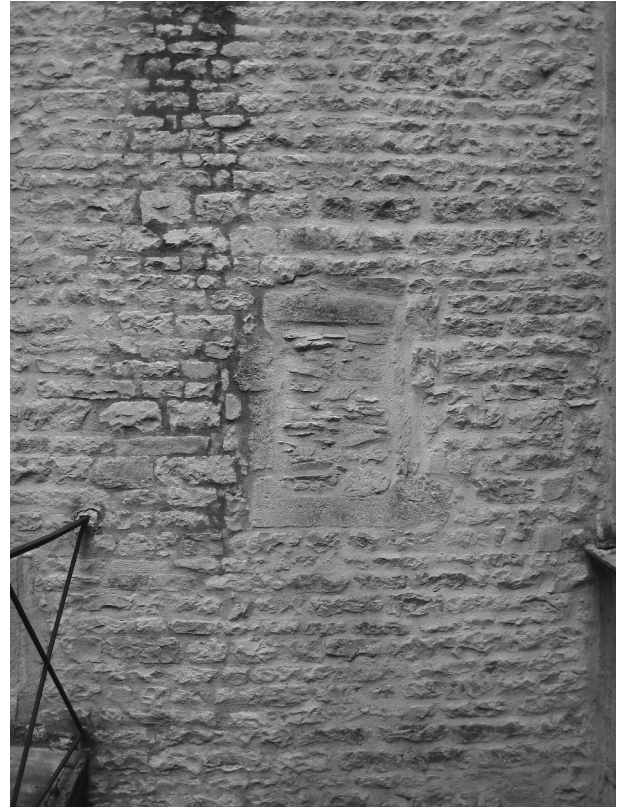
Fig. 4 : Détail de la maçonnerie de la façade (Photographie M. Rochette).
