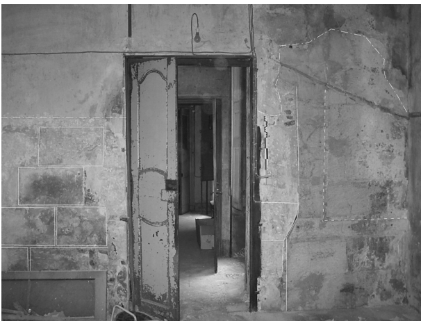
Fig. 7 : Vue des moellons standardisés du premier étage à gauche de la porte (Photographie R. Pellé).
