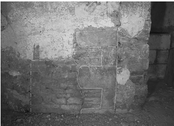
Fig. 17 : Vue du mur occidentale d'une des caves du rez-de-chaussée. A gauche de l'image, le petit appareil médiéval fait de moellons calcaire lié par un mortier orangé (Photographie R. Pellé).
