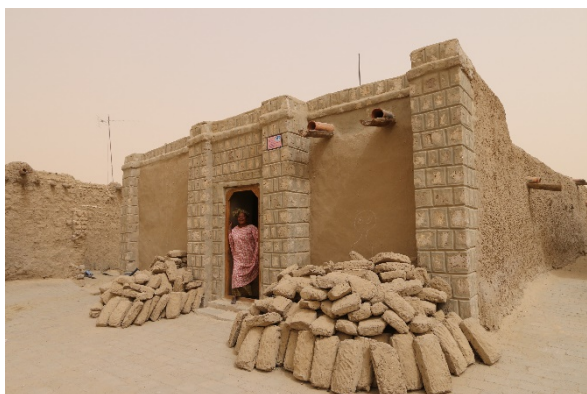
Une des maisons réhabilitée à Tombouctou
