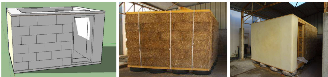
Figure 4. Module de 12 m 2 réalisé en paille porteuse – Enduit extérieur
