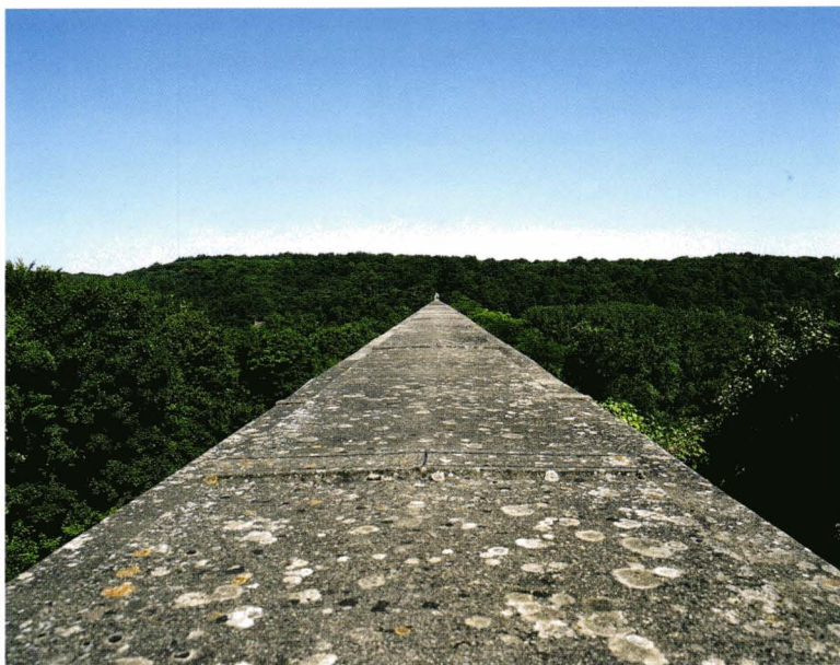
Le territoire et ses réseaux. L'aqueduc de Buc (78). Cliché C. Décamps, 2001.
