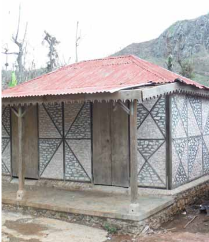
Maison modèle réalisée en 2013 lors d'une formation TCLA dans la commune d'Anse d'Hainault n'ayant subi aucun dégât après le passage de l'ouragan Matthew. © FICR
