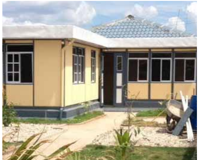
Rénovation et extension d'une maison à Gonaïves en 2015. © Atprocom
