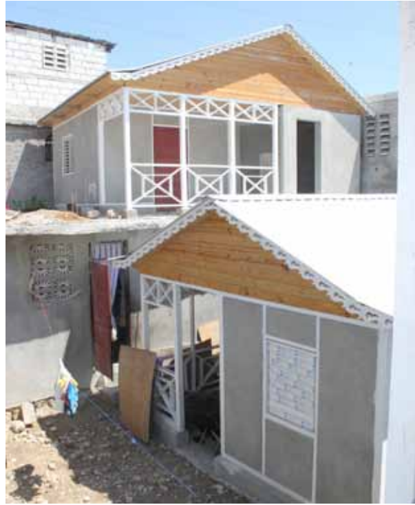
Plusieurs extensions ont été construites par les artisans d'EDM et d'Atprocom dans le quartier de Christ-Roi, de plain-pied (au premier plan) ou en surélévation (au second plan) © EDM
