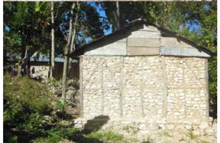
Exemple d'appropriation des améliorations techniques dans la construction de l'habitat rural. Parfois, les habitants modifient ces améliorations pour les optimiser selon leurs moyens économiques. Ici le contreventement est partiel et astucieusement placé en parties supérieures.
