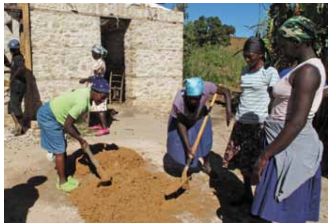
Les familles organisées en kombit construisent ensemble leurs maisons à l'aide d'un ou deux boss. La maison construite est en maçonnerie de pierres porteuse avec insertions bois, en continuité de la culture constructive locale.
