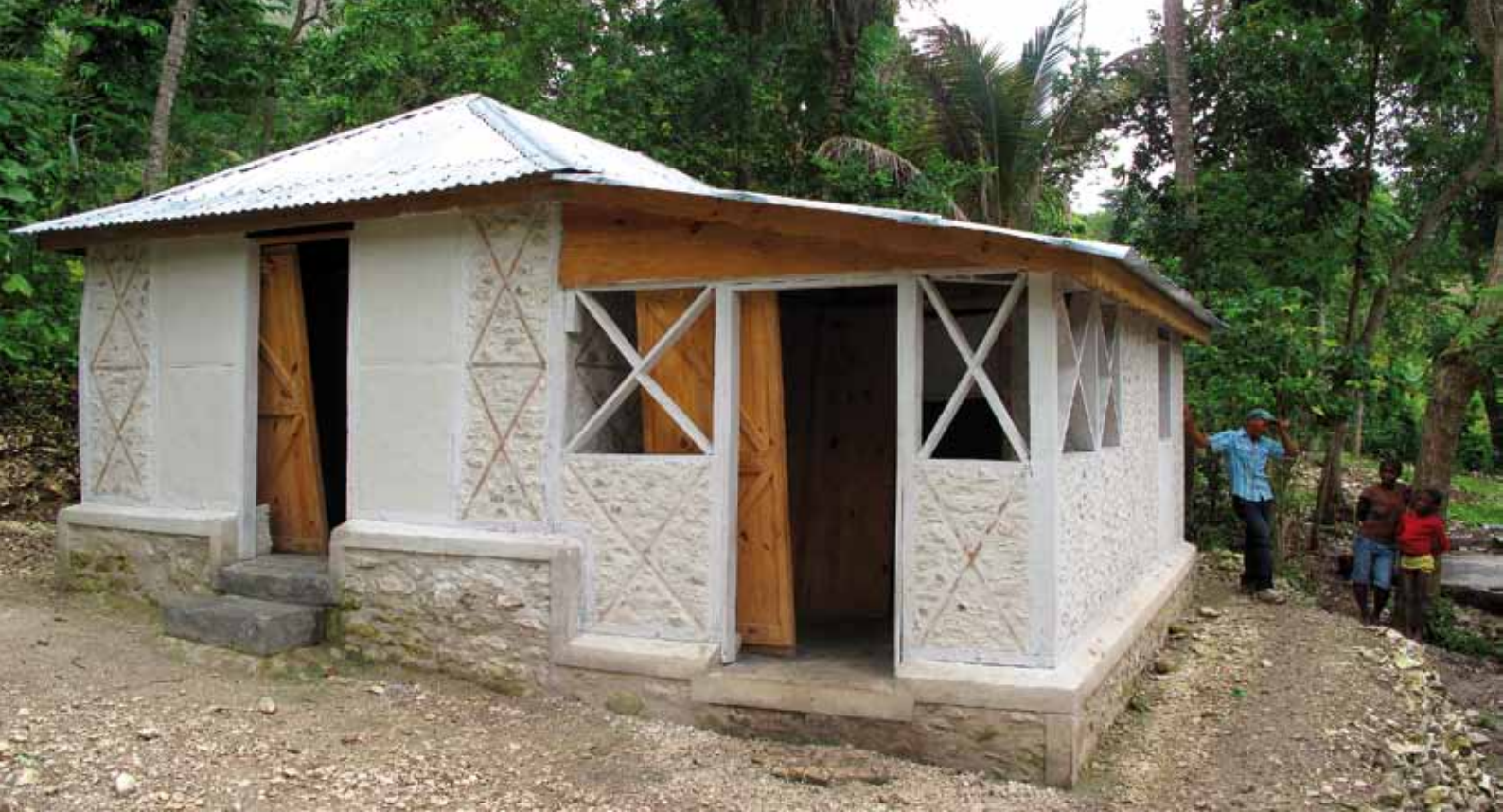
La modularité du système constructif proposé permet une extension ultérieure des maisons pour s'adapter aux ressources et aux besoins des habitants ou, comme ici à La Martinière, de s'adapter à la déclivité du terrain.
