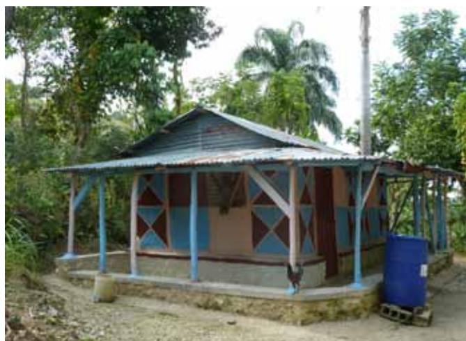
Chantier de réparation d'une maison existante dans le cadre du programme mené par EPPMPH (mai 2013). Ce chantier a été l'occasion d'améliorer certains détails constructifs, entre autres : contreventement de la structure, soubassement, ancrage de la toiture. © EPPMPH
