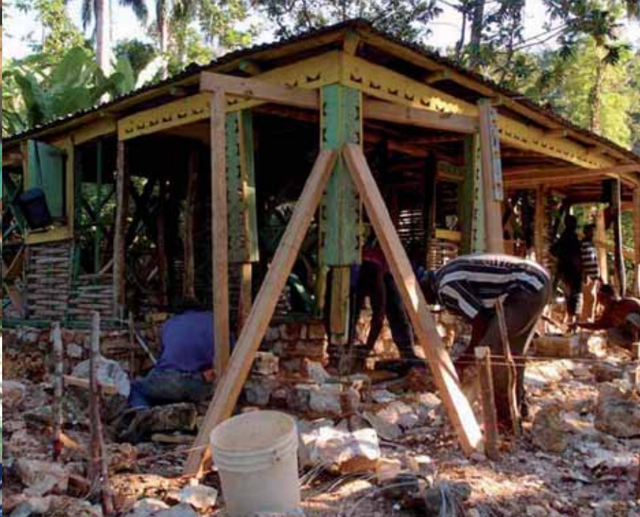
Chantier de réparation d'une maison existante mené par EPPMPH dans la zone de Coupeau, située à 6 heures de marche de la ville de Carrefour. Ce chantier a été l'occasion d'améliorer certains détails constructifs, entre autres : contreventement de la structure, soubassement et ancrage de la toiture.
