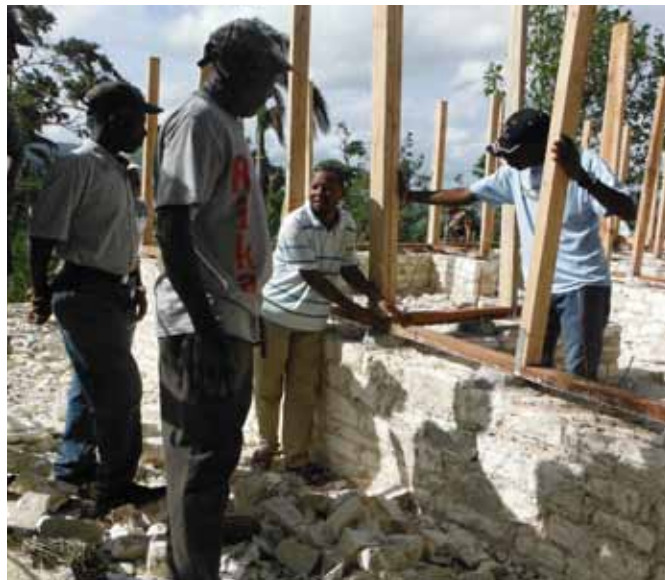
Les chantiers sont l'occasion de nombreux échanges avec les habitants et entre professionnels, parfois venus de loin.
