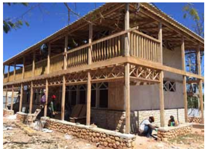
Chantier d'extension de l'école de Grand Boulage (fondamental 1er cycle) en 2017
