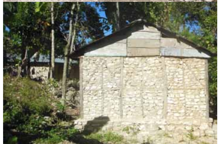
Exemple d'appropriation des améliorations techniques dans la construction de l'habitat rural. Parfois, les habitants modifient ces améliorations pour les optimiser selon leurs moyens économiques. Ici le contreventement est partiel et astucieusement placé en parties supérieures.
