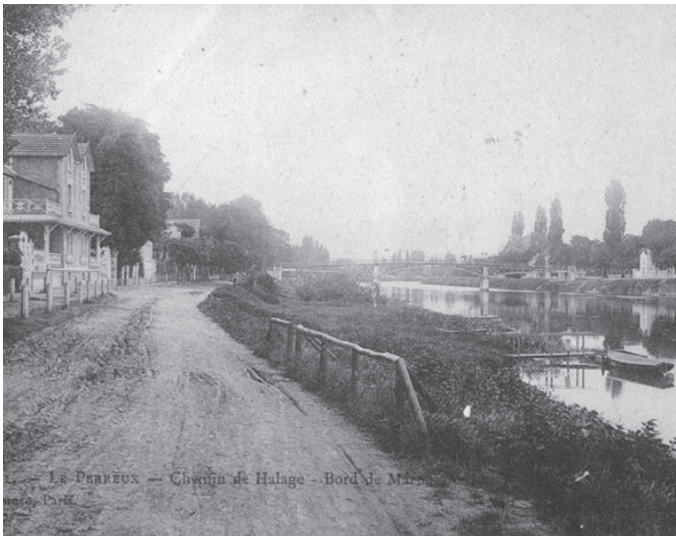
Vers 1900, le chemin de halage au Perreux ; au loin la passerelle piétonne de Bry, inaugurée en 1894. Sa construction fut entreprise afin de faciliter la circulation des habitants des nouveaux lotissements. (Coll. Part. © Inventaire général, repro. Stéphane Asseline)
