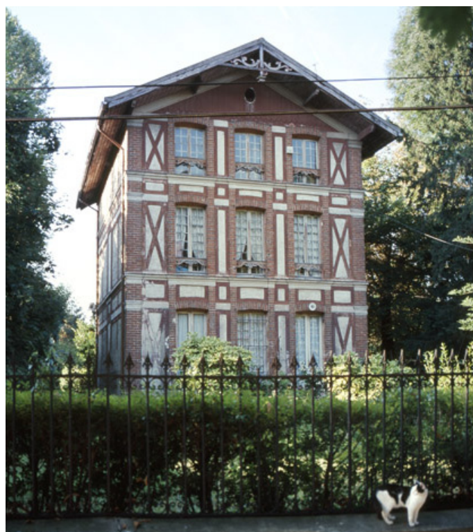
La plus ancienne maison conservée intacte dans l'île de Beauté (Nogent) croise des influences du chalet et celles de l'architecture néo-régionale à pan de bois et brique. Son élévation s'élevant en hauteur et son plan très ramassé s'expliquent par la crainte des inondations. (© Inventaire général. Cliché Stéphane Asseline)
