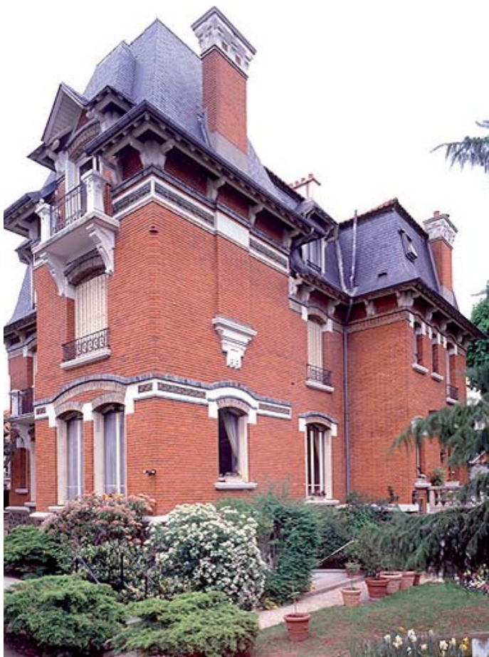
Villa construite avant la Première Guerre mondiale, 10 rue André-Pontier à Nogent-sur-Marne ; cette maison devrait bientôt disparaître, remplacée par un immeuble. (© Inventaire général. Cliché Stéphane Asseline. 2004)
