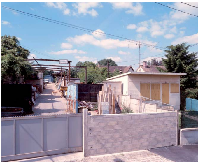
« Chantier » de l'entreprise « de travaux de bâtiment » Estrela, 42 chemin des Clotais, Champigny-sur-Marne. (© Inventaire général. Cliché Laurent Kruszyk. 2006).
