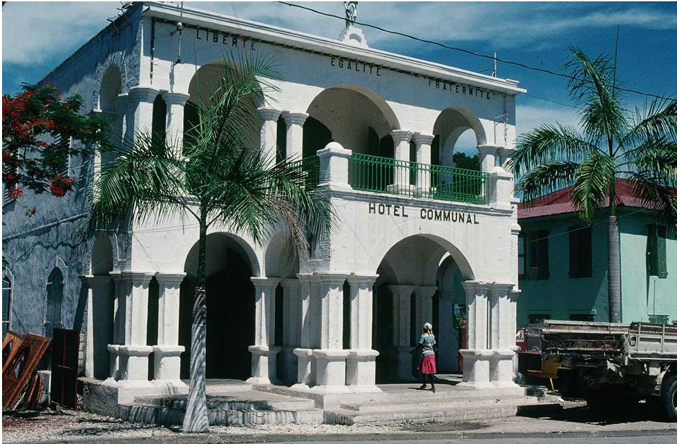
La mairie photographiée en 1997, avant les lourdes restaurations qui ont suivi le tremblement de terre. © MCC, MIGPC, 1997.
