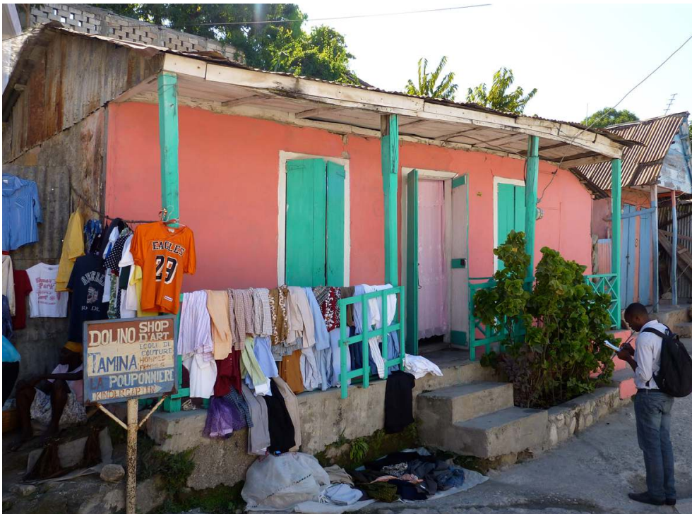
Maison en rez-de-chaussée avec mur gouttereau sur rue, à droite, au second plan, maison en rez-de-chaussée et mur pignon sur rue.
