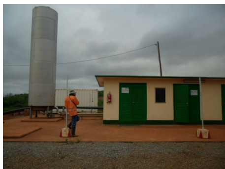
Photographie 1. Projet MDP de Nkol Foulou
