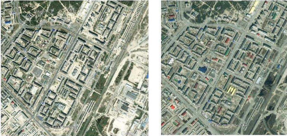
Figure 3. Urbanisme soviétique et transformations, vues du ciel.
