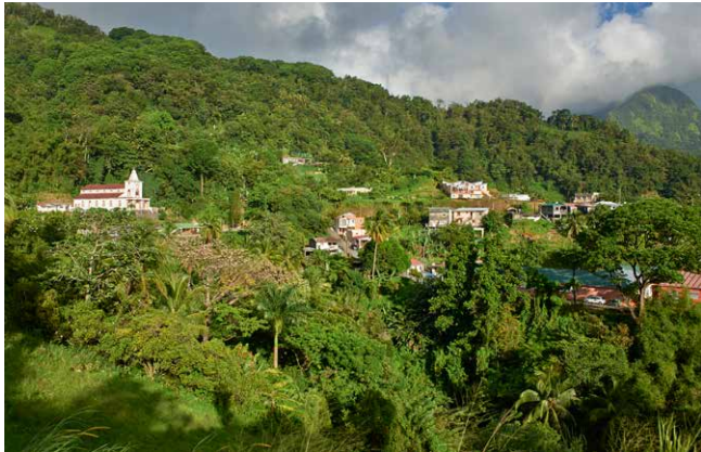
Les premiers et arrières plans de la zone tampon potentielle des abords agricoles de Fonds Saint-Denis, ici en b1 (ravines), b2 (agricultures, abords), b6 (routes avec points de vue) avec le cadre distant de son centre bourg. Observatoire photographique des paysages, BARRET Jean-Baptiste, 2009, DEAL Martinique
