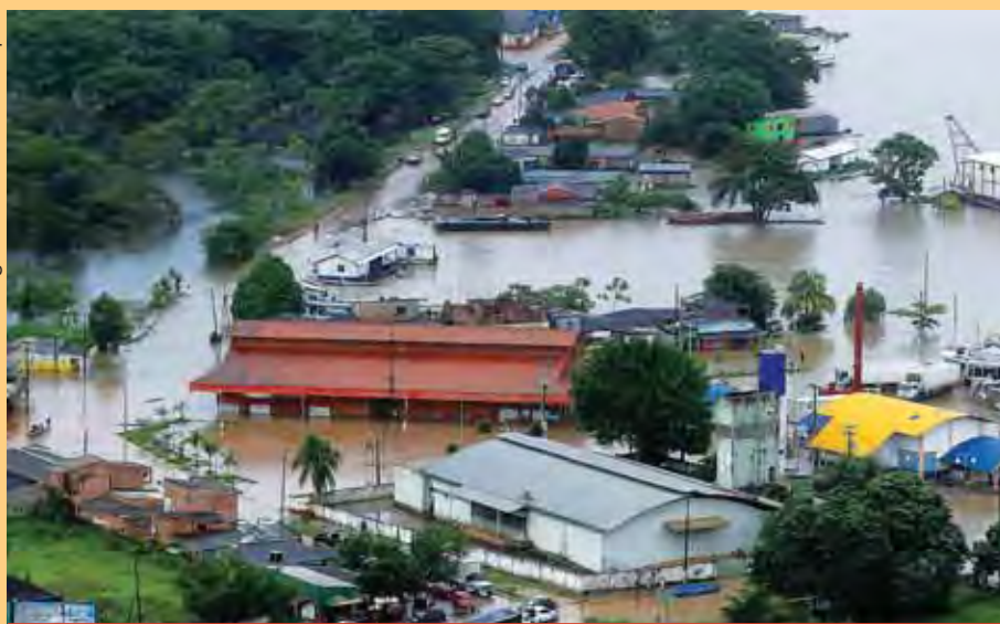
Dégâts liés à la crue du rio Madeira en 2014 au Brésil.
