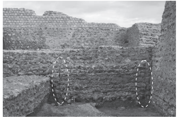
Fig. 8 – Parement sud du soubassement du canal central de l'égout avec empreintes de madriers pour le maintien d'un coffrage en bois (cliché : B. Bazin, SAVC).
