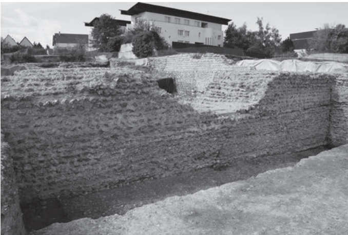
Fig. 7 – Parement est du soubassement du péribole oriental : les différentes étapes de construction. Sous la récupération de l'égout (au centre du cliché), trace du chaînage en biseau (cliché : B. Bazin, SAVC).
