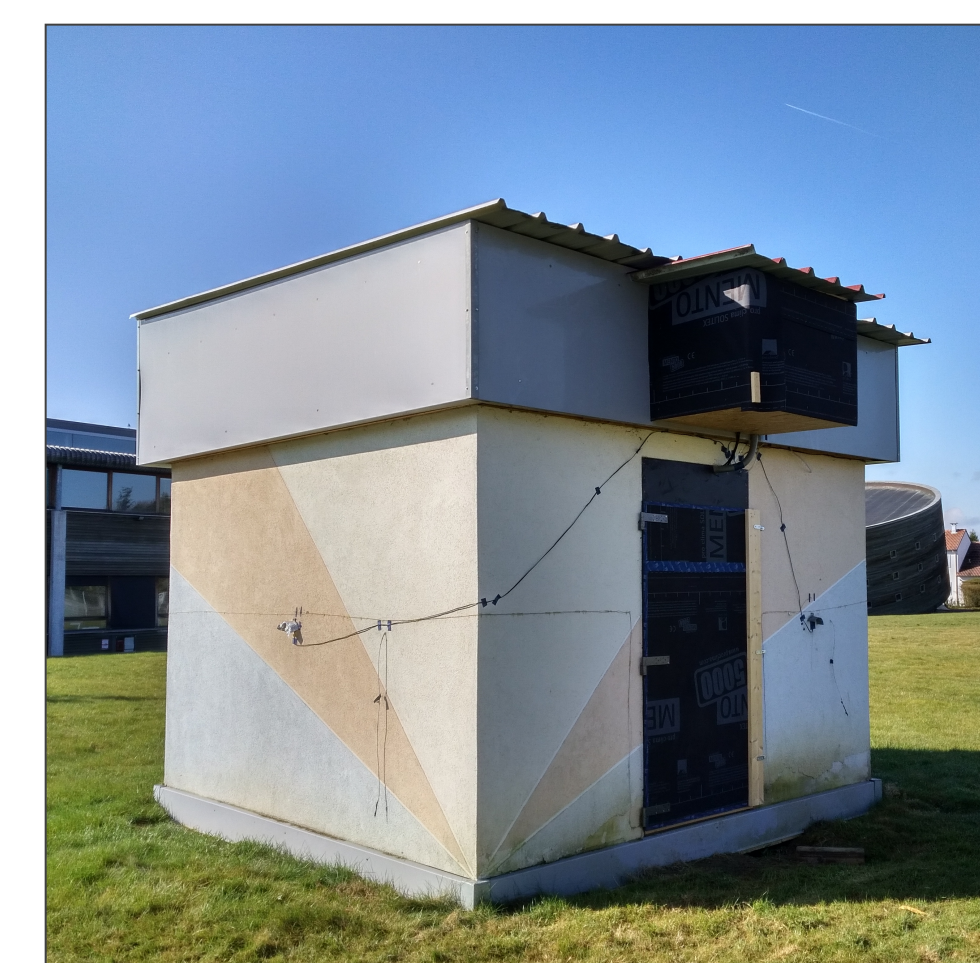
Cellule test en CLT
