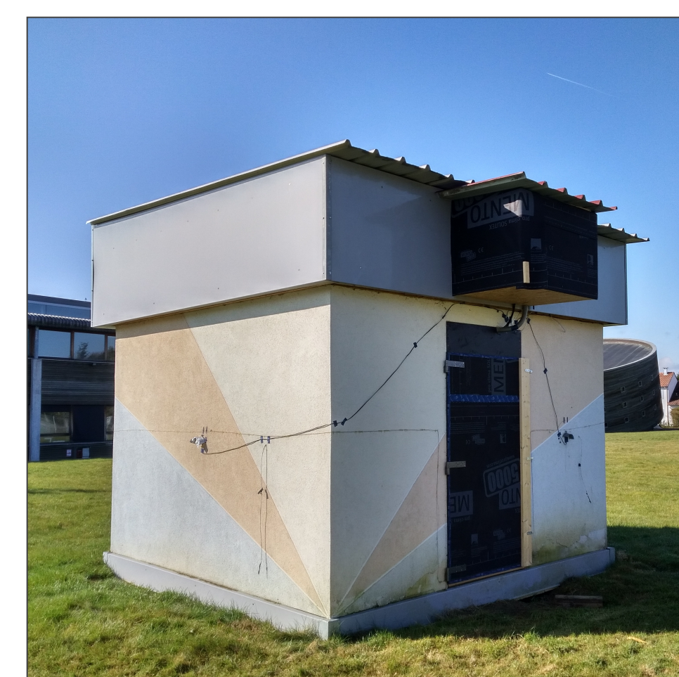
Cellule test en CLT
