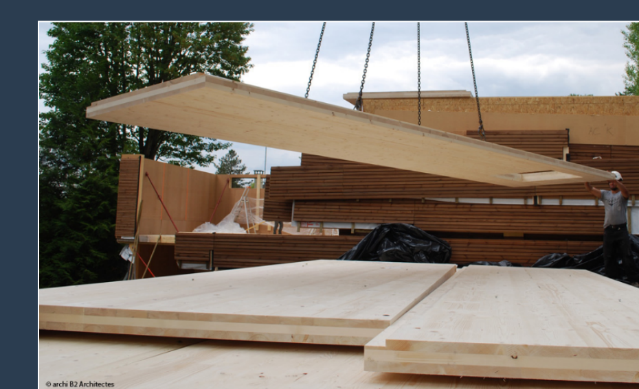
Levage panneaux (CLT)
