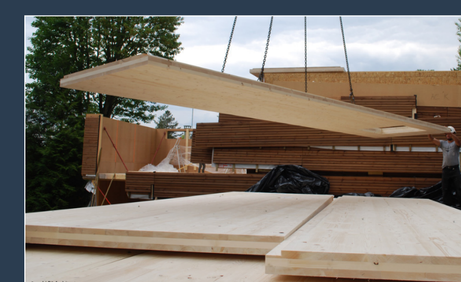
Levage panneaux (CLT)
