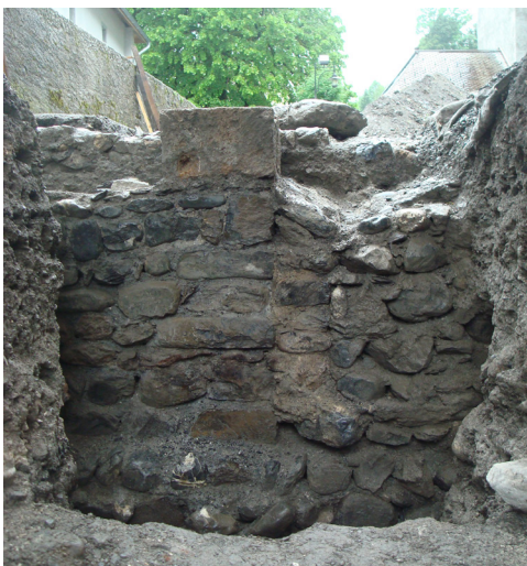
Fig. 4 - Baie et porte de la salle du chapitre (fouille 2016).
