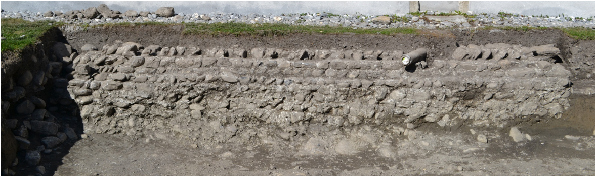
Fig. 18 - MUR 6001 (berme nord).
