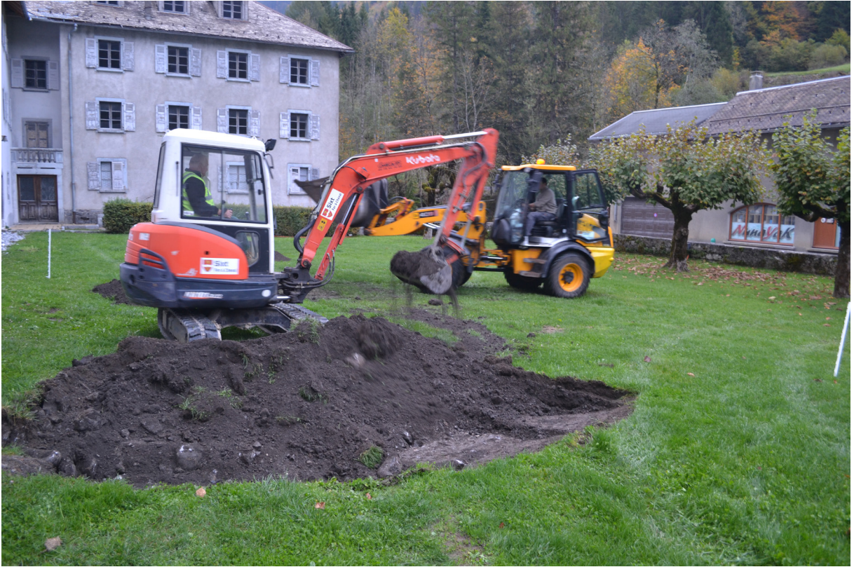
Fig. 15 - Décapage du sondage.
