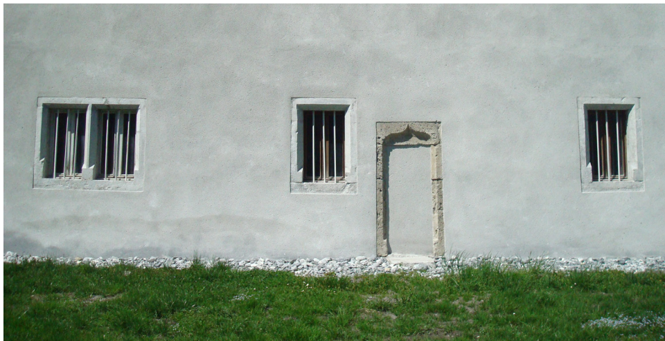
Fig. 11 - Façade sud du «logis». FEN 1038, FEN 1039, POR 1040, FEN 1041.
