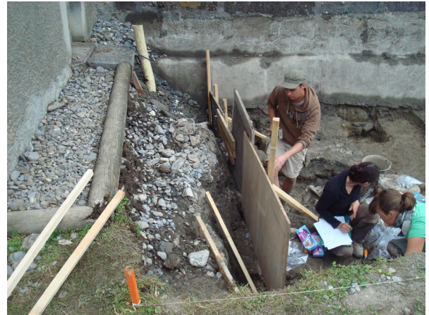
Fig. 10 - Etayage du drain de la berme ouest.
