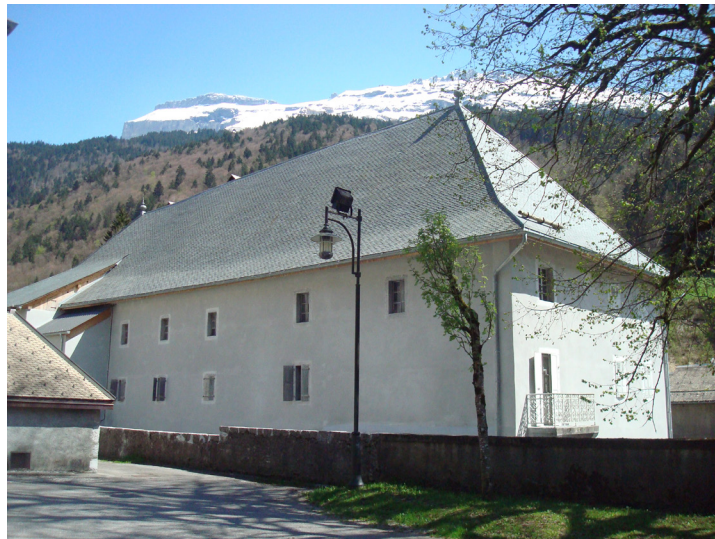
Fig. 3 - L'aile sud du bâtiment conventuel.
