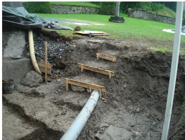
Fig. 11 - Marches aménagées dans la berme est.
