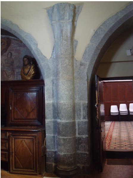
Fig. 5 - Sacristie: départs de voûte.
