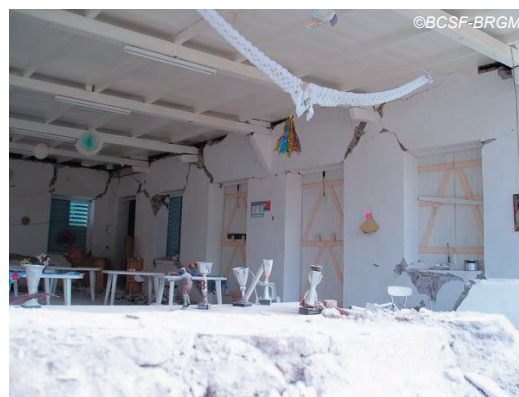
Fig. IV-16. Effondrement d'un mur du foyer du 3 ème âge. Bâtiment en maçonnerie brute, sans chaînage (vulnérabilité A-B, dommages de niveau 4).
