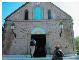
Fig. IV-26. Façade de l'église - sans dégât.
