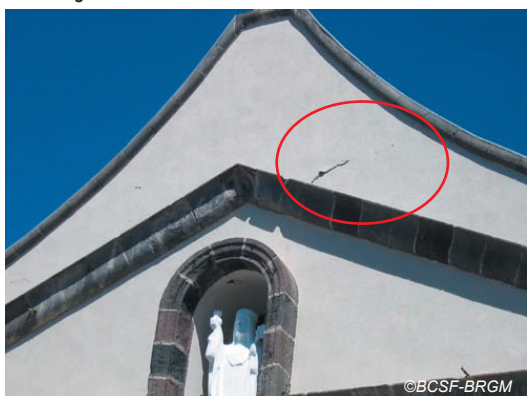
Fig. IV-42. Eglise paroissiale de Saint-Claude (XIX e s.) dommage de niveau 2 / vulnérabilité A.
