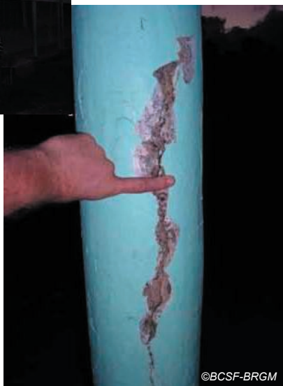
Fig. IV-34. Ecole de Sainte Marie : le poteau endommagé montré sur la photo de droite est le poteau d'angle de la photo de gauche. Il s'agit du seul poteau endommagé de toute l'école (dommage de niveau 3 isolé). Par ailleurs, un parement décoratif en béton courant le long du haut du bâtiment, fortement endommagé par le séisme, a dû être détruit pour sécuriser le bâtiment.
