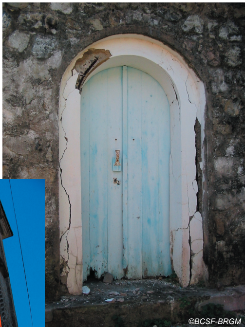
Fig. IV-24. Terre-de-Haut - porte du clocher de l'église.
