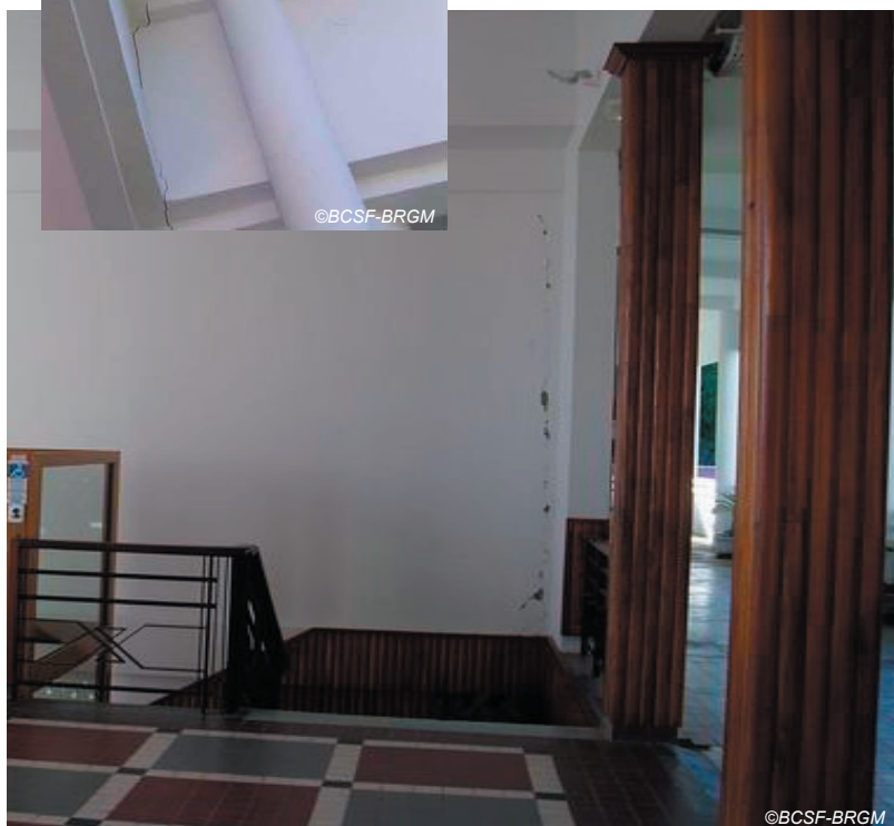
Fig. IV-49. Fissures dans le bâtiment de la mairie de Trois-Rivières (dommages de niveau 2).
