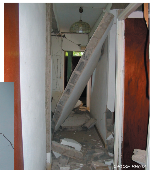
Fig. IV-23. Terre-de-Haut - maison individuelle comportant des dégâts de degré 3 à 4 sur des parties porteuses et non porteuses.
