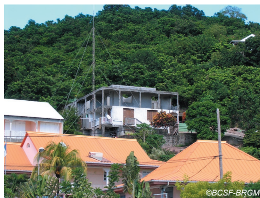
Fig. IV-10. Exemples de constructions de Petites-Anses (proche de la zone la plus affectée) sans dégât apparent.
