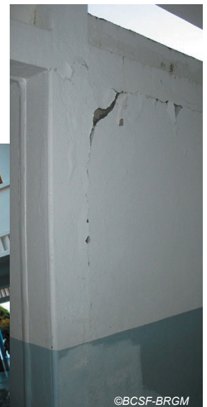
Fig. IV-74. Bouillante - école mixte de Village - fissurations entre le mur de remplissage et la structure .
