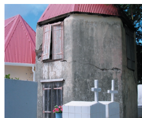
Fig. IV-15. Dommages sur le clocher et le fronton de l'église (mur en moellons - vulnérabilité A).
