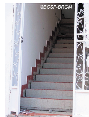
Fig. IV-18. Décrochement de l'escalier de l'hôtel.
