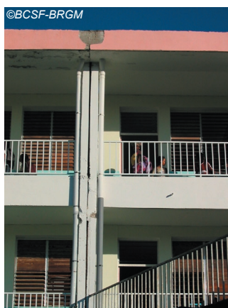
Fig. IV-78. Dégâts au niveau du joint de dilatation.
