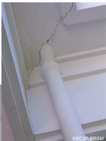
Fig. IV-49. Fissures dans le bâtiment de la mairie de Trois-Rivières (dommages de niveau 2).
