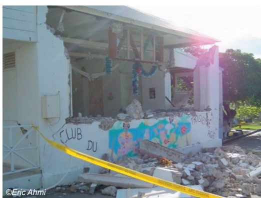
Fig. IV-16. Effondrement d'un mur du foyer du 3 ème âge. Bâtiment en maçonnerie brute, sans chaînage (vulnérabilité A-B, dommages de niveau 4).
