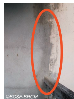
Fig. IV-93. Dommages sur la seule maison d'habitation de la commune identifiée comme ayant subi des effets dus au séisme (dommage de niveau 2 sur un bâtiment très vulnérable ayant connu des réparations à plusieurs reprises).
