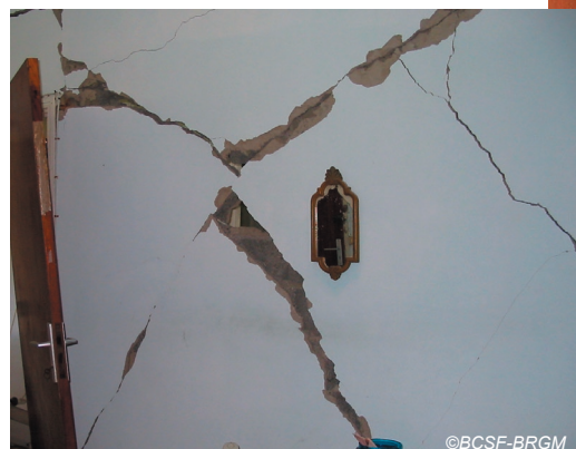
Fig. IV-23. Terre-de-Haut - maison individuelle comportant des dégâts de degré 3 à 4 sur des parties porteuses et non porteuses.
