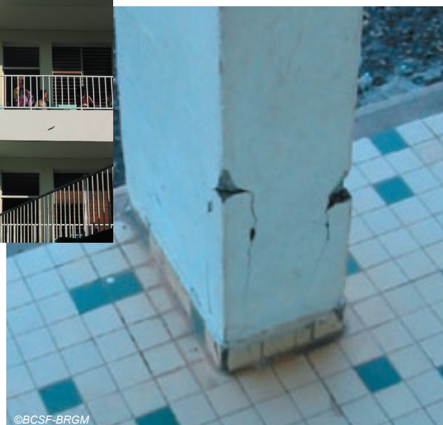
Fig. IV-76. Vieux-Habitants - école du Beau - dégâts de niveau 1 à 2 sur structure poteau-poutre + remplissage ou sur pilier.
