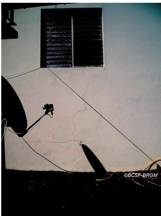
Fig. IV-85. Les seuls dégâts sur l'unique habitation individuelle de Vieux Fort ayant fait l'objet d'une déclaration en mairie relèvent de nombreuses fines fines (intérieures, extérieures), ainsi qu'un dommage sur un élément de toiture.
