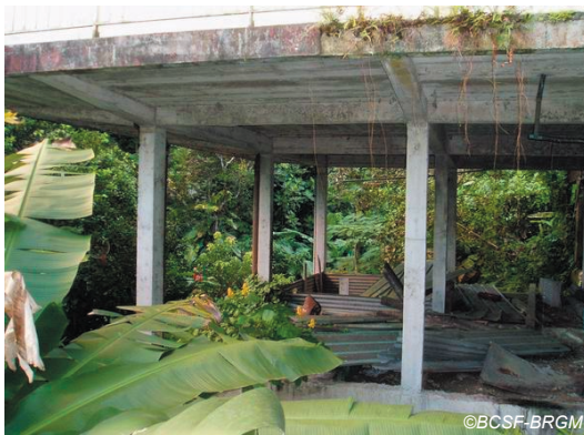
Fig. IV-53. Maison d'apparence très vulnérable n'ayant subi aucun dommage visible de l'extérieur. Lieu dit du « Soldat ».
