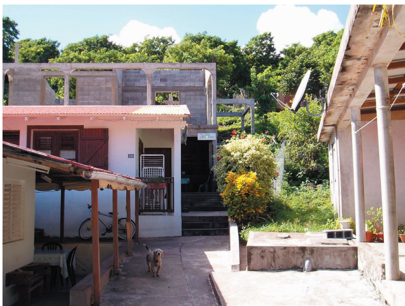
Fig. IV-2. Exemple de construction neuve poteau-poutre (Terre-de-Bas - Petites Anses)
