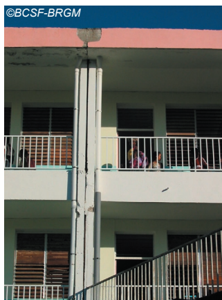
Fig. IV-78. Dégâts au niveau du joint de dilatation.
