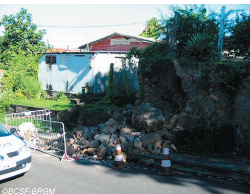
Fig. IV-65. Eboulement d'un mur en partie haute de la commune de Basse-Terre.
