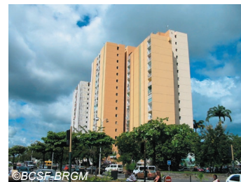
Fig. IV-87. Tours de la Gabarre - sans dégât.
