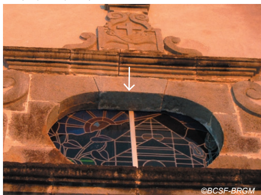
Fig. IV-77. Descente de la clef-de voûte de l'église Saint-Joseph (18e s.) aux puissants contreforts.
