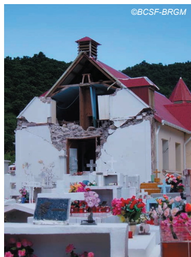
Fig. IV-15. Dommages sur le clocher et le fronton de l'église (mur en moellons - vulnérabilité A).
