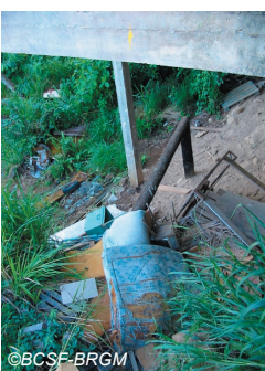
Fig. IV-64. Bâtiment "Ex-Pharmacie" servant d'atelier particulièrement vulnérable et dangereux (pilotis) - Trou dans la dalle du rez-de-chaussée.
