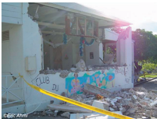
Fig. IV-16. Effondrement d'un mur du foyer du 3 ème âge. Bâtiment en maçonnerie brute, sans chaînage (vulnérabilité A-B, dommages de niveau 4).
