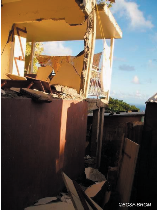
Fig. IV-50. Lieu dit La Plaine. Vue de la maison la plus touchée dans le quartier (niveau 4) et affaissement de terrain au voisinage, au bord de la ravine.
