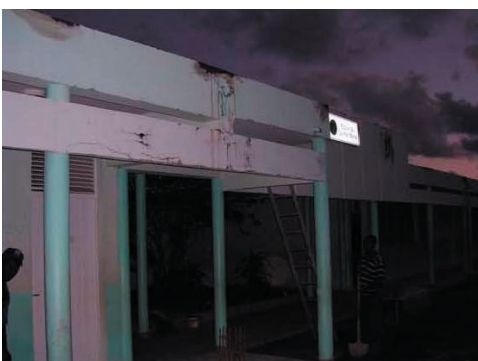
Fig. IV-34. Ecole de Sainte Marie : le poteau endommagé montré sur la photo de droite est le poteau d'angle de la photo de gauche. Il s'agit du seul poteau endommagé de toute l'école (dommage de niveau 3 isolé). Par ailleurs, un parement décoratif en béton courant le long du haut du bâtiment, fortement endommagé par le séisme, a dû être détruit pour sécuriser le bâtiment.
