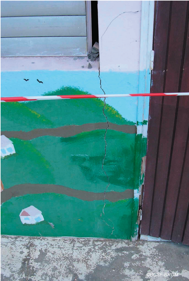
Fig. IV-13. Dommages sur la structure à l'école maternelle de Petites-Anses (vulnérabilité B).
