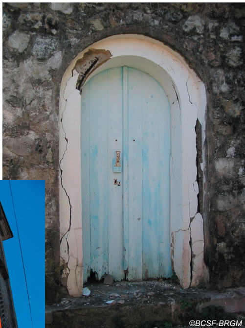
Fig. IV-24. Terre-de-Haut - porte du clocher de l'église.
