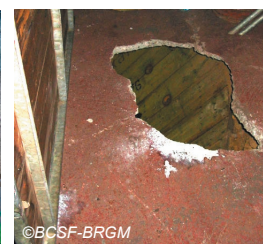
Fig. IV-64. Bâtiment "Ex-Pharmacie" servant d'atelier particulièrement vulnérable et dangereux (pilotis) - Trou dans la dalle du rez-de-chaussée.
