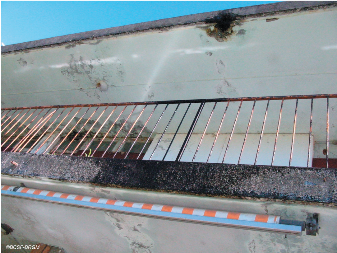
Fig. IV-4. Exemple d'une construction rongée par des problèmes d'infiltration augmentant la vulnérabilité aux secousses sismiques - St-Claude.
