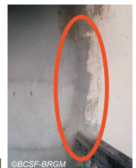
Fig. IV-93. Dommages sur la seule maison d'habitation de la commune identifiée comme ayant subi des effets dus au séisme (dommage de niveau 2 sur un bâtiment très vulnérable ayant connu des réparations à plusieurs reprises).
