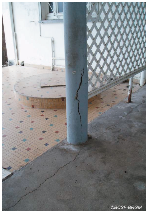
Fig. IV-56. Dommages sur les poteaux du bâtiment principal de l'ancien hôpital de Marie Galante (dommages de niveau 2 et 3 sur éléments porteurs). Le bâtiment est très ancien (vulnérabilité B).
