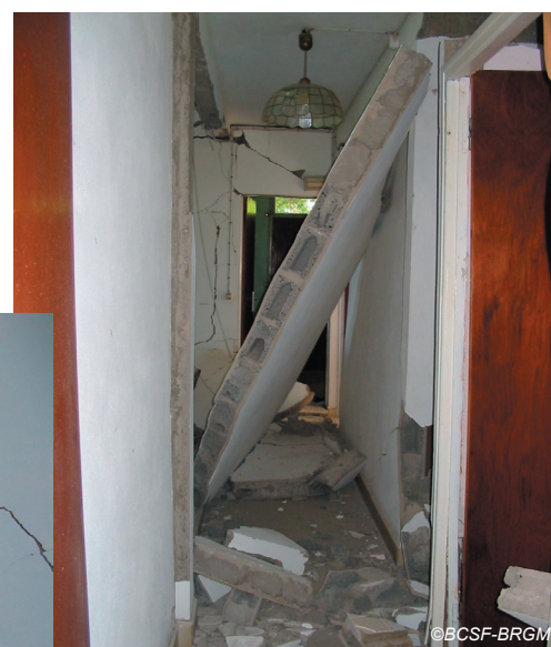
Fig. IV-23. Terre-de-Haut - maison individuelle comportant des dégâts de degré 3 à 4 sur des parties porteuses et non porteuses.
