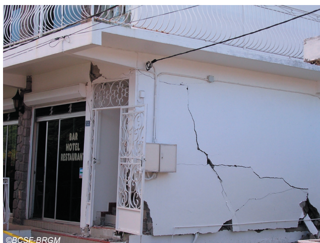
Fig. IV-16. Effondrement d'un mur du foyer du 3 ème âge. Bâtiment en maçonnerie brute, sans chaînage (vulnérabilité A-B, dommages de niveau 4).
