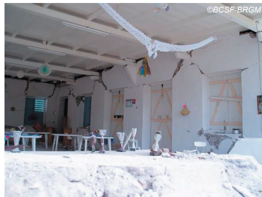
Fig. IV-16. Effondrement d'un mur du foyer du 3 ème âge. Bâtiment en maçonnerie brute, sans chaînage (vulnérabilité A-B, dommages de niveau 4).
