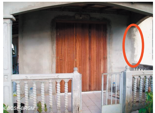
Fig. IV-93. Dommages sur la seule maison d'habitation de la commune identifiée comme ayant subi des effets dus au séisme (dommage de niveau 2 sur un bâtiment très vulnérable ayant connu des réparations à plusieurs reprises).
