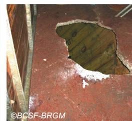
Fig. IV-64. Bâtiment "Ex-Pharmacie" servant d'atelier particulièrement vulnérable et dangereux (pilotis) - Trou dans la dalle du rez-de-chaussée.
