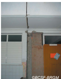
Fig. IV-38. Dégâts suite à l'entrechoquement des corps de bâtiment à l'école mixte du bourg.
