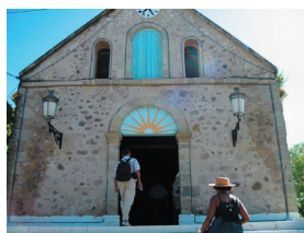
Fig. IV-26. Façade de l'église - sans dégât.
