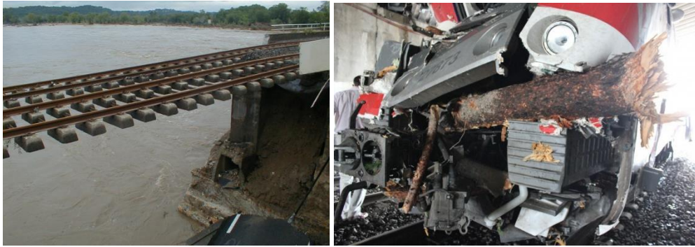
Figure 4 : Accidents régulièrement mentionnés (a) Effet de la crue du Gardon en 2002 sur la ligne Nîmes-Alès (sources : Dubost, 2017) ; (b) Accident du TER consécutif à la chute d'un arbre sur la commune de Saint Aunès en 2016 (source : SDIS 34).
