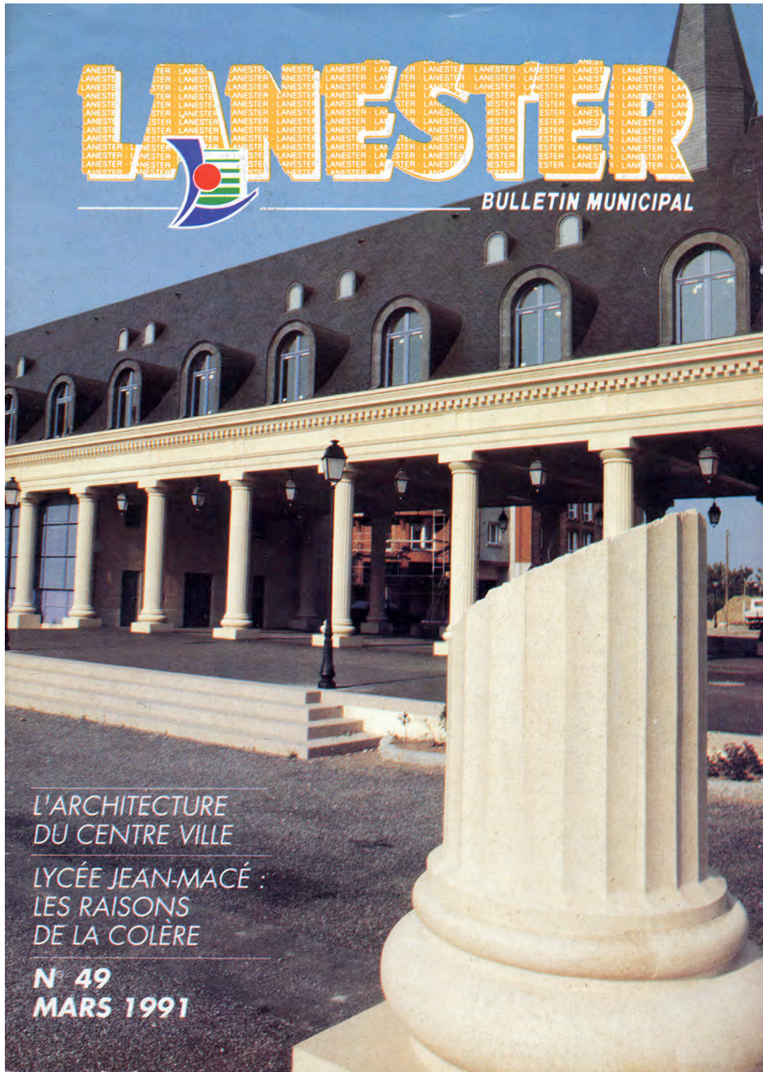
Lanester, bulletin municipal. La halle commerciale. Le clin d'œil post-moderne de la colonne tronquée , au premier plan, réfère aux images ironiques popularisées par les ouvrages de Charles Jencks, et largement utilisées dans la production des décennies 1980-1990.
