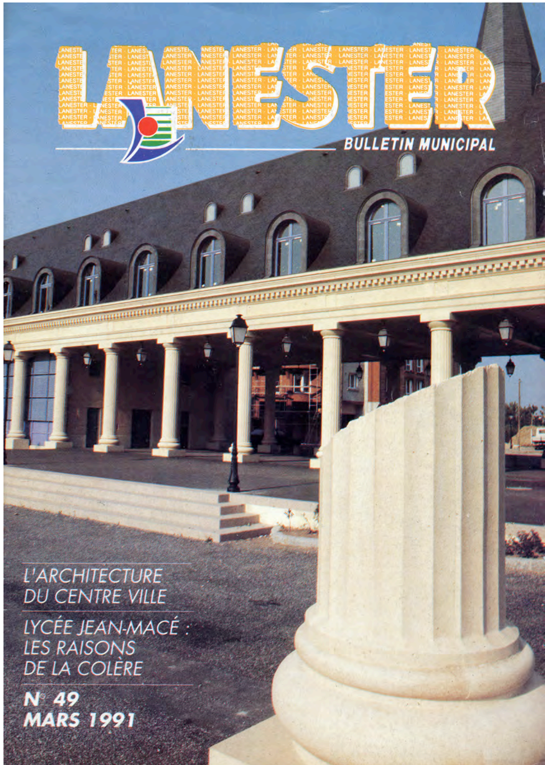
Lanester, bulletin municipal. La halle commerciale. Le clin d'œil post-moderne de la colonne tronquée, au premier plan, réfère aux images ironiques popularisées par les ouvrages de Charles Jencks, et largement utilisées dans la production des décennies 1980-1990.
