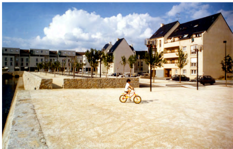
La réalisation des espaces publics a tiré parti d'une contrainte particulière du site : la présence d'un bassin d'orage, transformé en plan d'eau paysager, à l'image d'une technique largement utilisée à Marne-la-Vallée.
