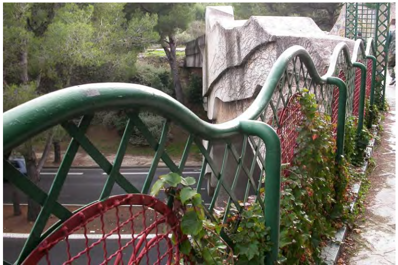
[Image 2b, 2c] ISTRES, parc des Salles : vue actuelle de la passerelle conçue et réalisée par Bernard Lassus de 1979 à 1984 ; détail (photos de l'auteur, 2008).
