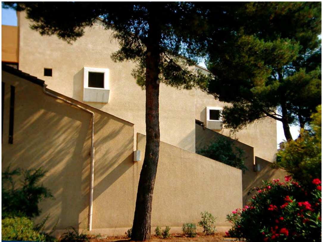
VITROLLES : opération de logements collectifs et intermédiaires (arch. Mario Fabre).
