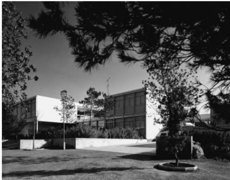
Figure 6: Vue de détail du CES n. d. [vers 1973], cl. Biaugeaud [fonds ATM/IFA/CAPA].
