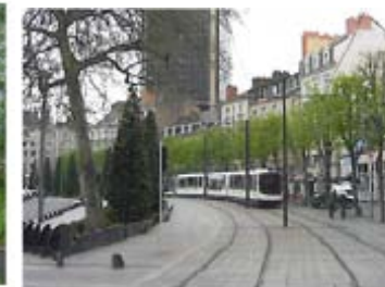
requalification de l'espace rue par le tram, Nantes, France
