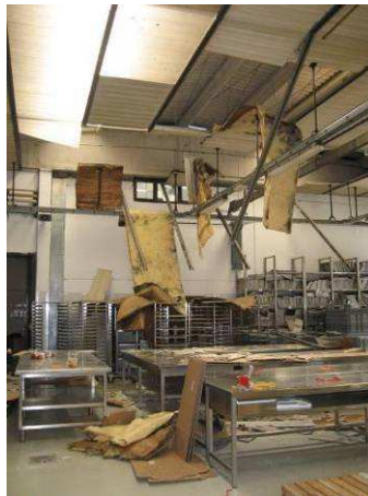
Bâtiment industriel, Bazzano (L'Aquila)
