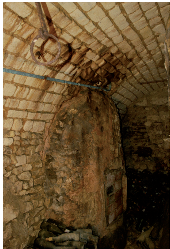
Figure 114 : La cave sud du n° 17 – vue générale du volume occidental de la cave prise depuis le pied de l'escalier en regardant vers l'Ouest. Au milieu, un ouvrage cylindrique marque l'emplacement du puits mitoyen avec le n° 15 au sud. Le mur du fond sert de soutènement pour des remblais dans lesquels la cave a été en partie creusée (cliché DSC_0422).
