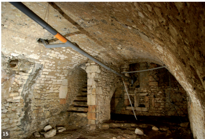
Figure 16 : Vue générale de la cave prise depuis l'Ouest. A gauche, la porte représente un accès primitif depuis la cour. A droite, le mur occidental possède des vestiges de placards identiques à ceux du mur oriental (cliché DSC_0628.JPG).
