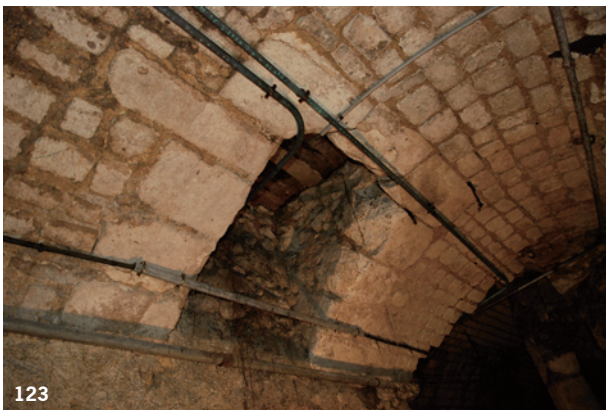
Figure 118 : La cave sud du n° 17 – vue de l'articulation entre le volume oriental et celui de la partie ouest. Le raccord entre les deux travées des voûtes est assez maladroit (cliché DSC_0417).
