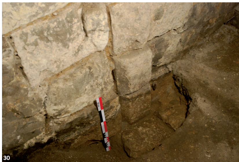
Figure 27 : Vue générale de la partie ouest du mur sud avec la porte primitive et l'emplacement de la retombée de la première travée des croisées d'ogives. L'arasement de celle-ci correspond au départ de la voûte en berceau (cliché DSC_0633.JPG).
