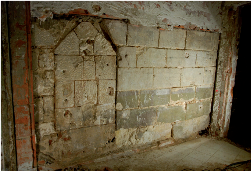
Figure 65 : Vue générale de la partie ouest du mur nord dans l'ancien espace de cour ou de jardin, prise depuis le Sud-Ouest. A gauche, on observe l'emplacement d'un puits avec le parement en pierre de taille de l'extrémité orientale du mur à droite (cliché DSC_0585).
