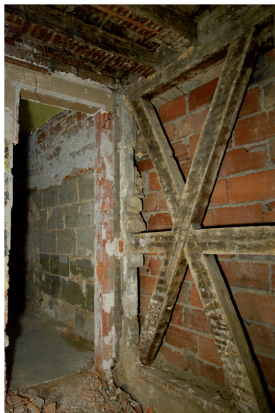
Figure 61 : Vue générale de l'extrémité ouest des cloisons en pans de bois du mur nord. A gauche, la maçonnerie en pierre de taille représente le mur de clôture de la limite nord de la parcelle (cliché DSC_0581).
