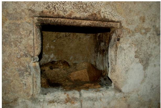
Figure 127 : La cave nord du n° 17 – détail du placard aménagé dans l'épaisseur du mur ouest, près du sol (cliché DSC_0446).
