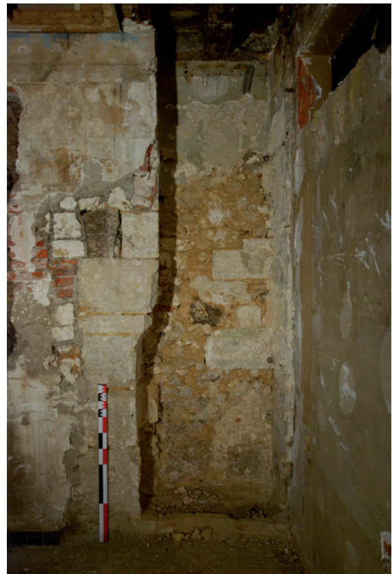
Figure 48 : Le pan de mur à droite de la cheminée. Des blocs du montant d'une porte sont clairement visibles, chaînés à la maçonnerie du mur sud (cliché DSC_0562).
