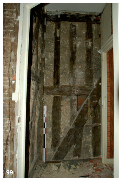
Figure 98 : Le mur nord au deuxième étage – détail du retour du décrochement dans le mur (éch. 1 m). Noter l'assemblage avec des pièces diagonales par rapport aux poteaux verticaux des niveaux inférieurs (cliché DSC_0386).
