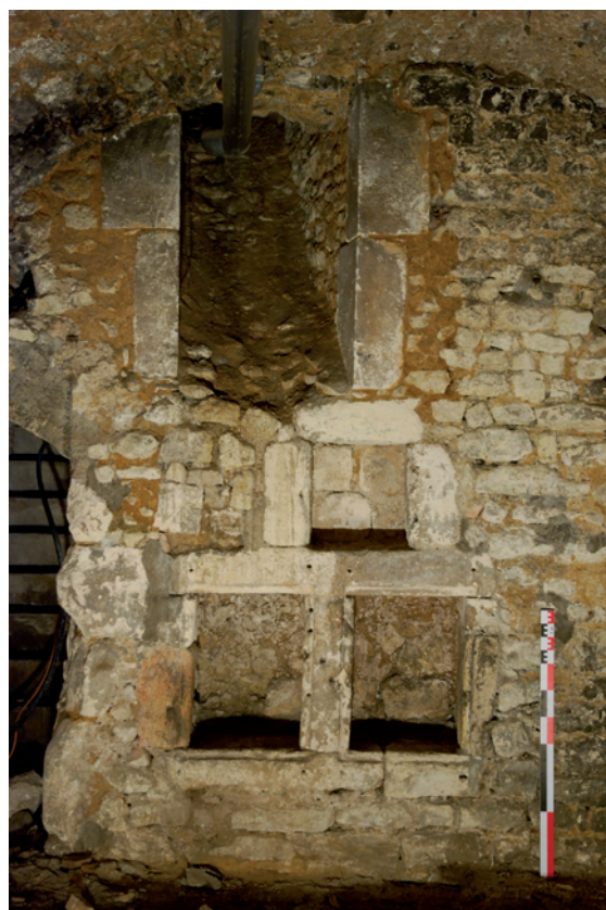
Figure 32 : Vue rapprochée des aménagements du mur ouest de la cave (éch. 1 m). Les deux casiers en bas font partie d'un bloc de quatre placards contemporains à la première phase de la cave. Le grand soupirail est un ajout tardif, sans doute au cours du XVIII e ou du XIX e siècle (clichié DSC_0631.JPG).
