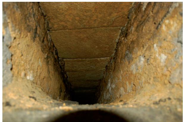
Figure 128 : La cave nord du n° 17 – détail du soupirail dans la partie supérieure du mur ouest avec une couverture de dalles en calcaire (cliché DSC_0450).
