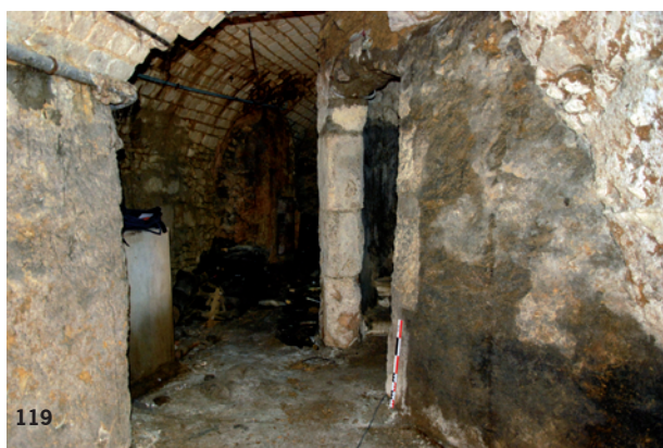
Figure 115 : La cave sud du n° 17 – détail du parement du mur nord de la partie orientale de la cave (éch. 1 m). Noter le contraste entre l'appareillage en moellons dégrossis du mur et celui en moellons d'appareil de la voûte (cliché DSC_0426).
