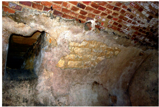
Figure 126 : La cave nord du n° 17 – Vue générale du mur ouest, prise depuis le Nord-Ouest. Noter l'utilisation d'un petit appareillage en moellons de calcaire pour le mur et de la brique pour la voûte elle-même. Il pourrait agir d'une reconstruction plus tardive (cliché DSC_0439).
