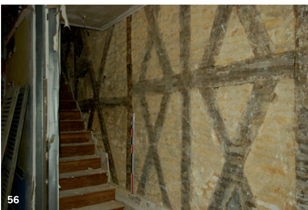
Figure 54 : Le mur nord – vue des trois travées en pans de bois de la partie orientale avec la façade sur rue visible à droite (cliché DSC_0530).
