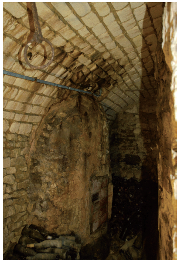
Figure 71 : La cave du n° 17 de la place Planchat. Vue de la maçonnerie cylindrique enfermant le puits dans la partie ouest de la cave (cliché DSC_0589).
