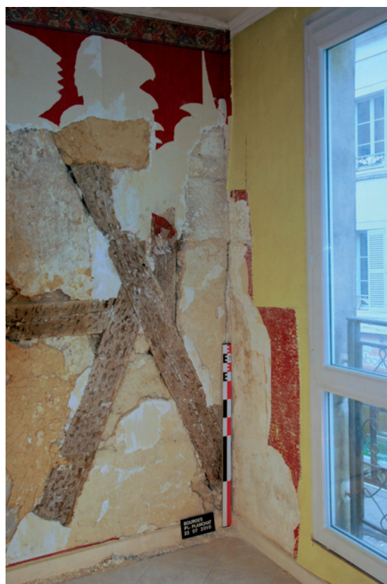
Figure 94 : Le mur nord du premier étage – vue rapprochée de la liaison entre la façade orientale en pierre, plaquée contre l'extrémité du mur nord en pans de bois (cliché DSC_0311).
