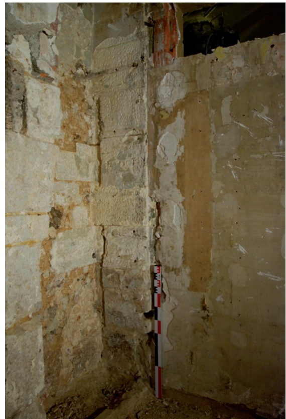
Figure 49 : Vue rapprochée du pan de mur entre la cheminée du rez-de-chaussée et l'ancienne façade arrière de la maison (éch. 1 m). La cloison à droite reprend l'emplacement de l'ancienne façade. Le feuillure d'une porte est visible immédiatement à gauche de celle-ci (cliché DSC_0566).
