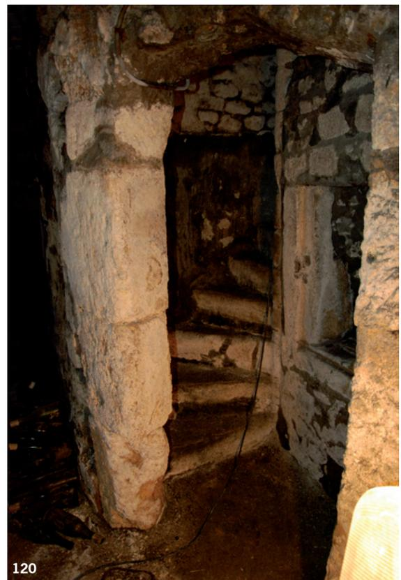
**Figure 115** : La cave sud du n° 17 – détail du parement du mur nord de la partie orientale de la cave (éch. 1 m). Noter le contraste entre l'appareillage en moellons dégrossis du mur et celui en moellons d'appareil de la voûte (cliché DSC\_0426).
