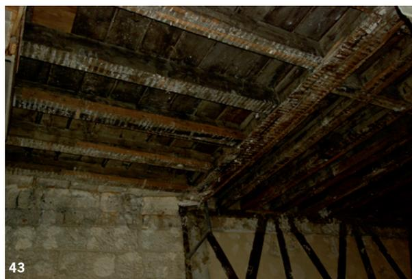
A partir de l'ouest, les deux premiers poteaux verticaux comportent des mortaises qui signalent la présence d'éléments en bois perpendiculaires qui s'emboîtaient dans ces pièces (fig. 36). Il est tentant d'y voir l'emplacement de moulures ou d'autres dispositifs pour des aménagements comme des portes ou des cloisons internes. Cette hypothèse est confortée par le fait que la face de chacun de ces poteaux a été bûchée.
