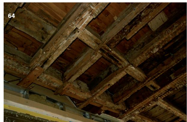
**Figure 64** : Les solives au-dessus de l'emplacement supposé de la cage d'escalier, prise de l'Ouest. Les mortaises des éléments verticaux de la structure de la cage d'escalier sont visibles (cliché DSC\_0646).
