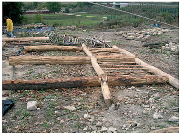
Fig. 22a - Préparation et assemblage des pans de bois au sol.
