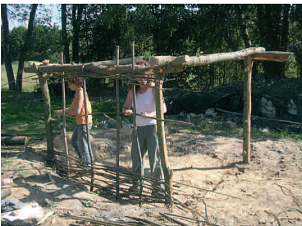
Fig. 8 - Pose en alternance des piquets, mis en tension par les baguettes du clayonnage.
