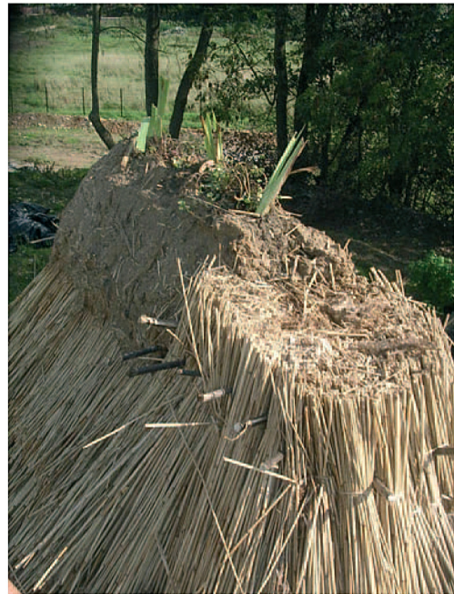
Fig. 17 - Pose de plantes grasses (iris, joubardes, fougères) dans l'argile sur le faîtage.
