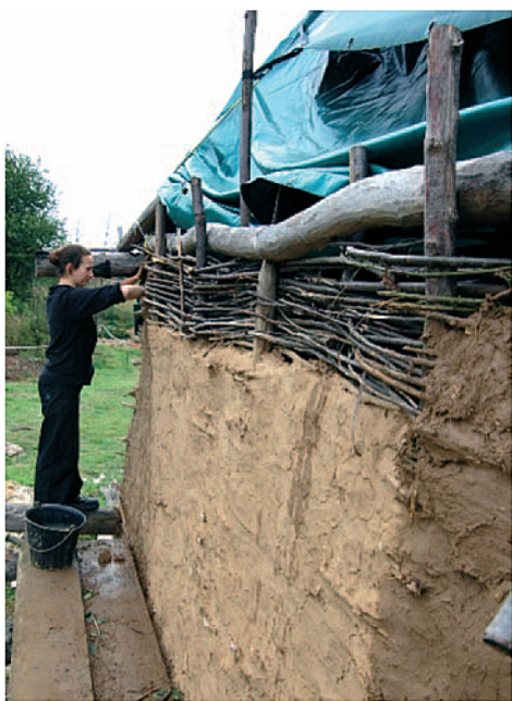
Fig. 34 - Cloison avec les piquets verticaux disposés de part et d'autre de la sablière haute, et mis en pression par le clayonnage.
