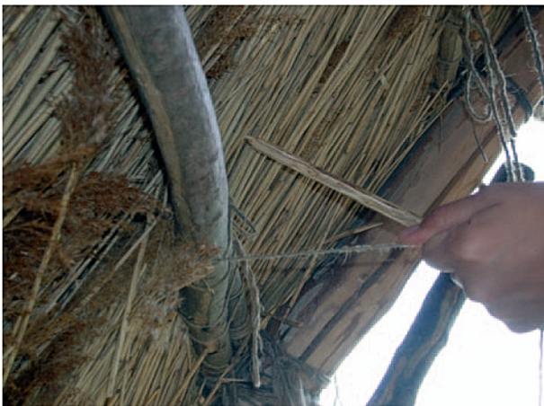
Fig. 32 - Ligature du roseau au lattis à l'aide d'une navette
