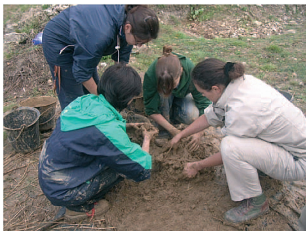
Fig. 13 - Mélange de l'argile à la paille pour la confection du torchis.
