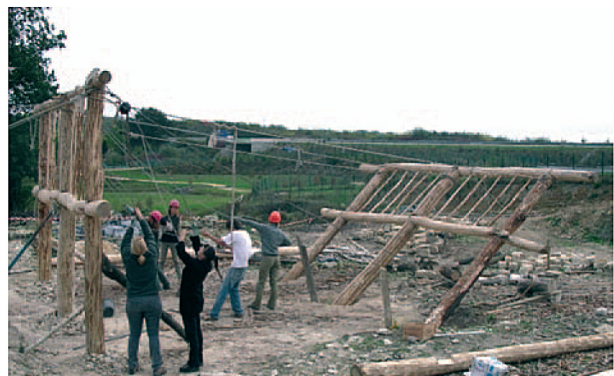
Fig. 22c - Levage du second pan à l'aide de cordages accrochés au premier pan.
