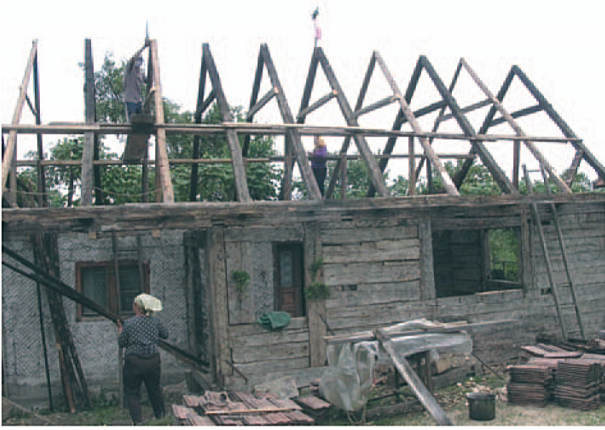
Fig. 30 - Charpente à chevrons-formant-fermes d'une maison de la région de Maramures en Roumanie.
