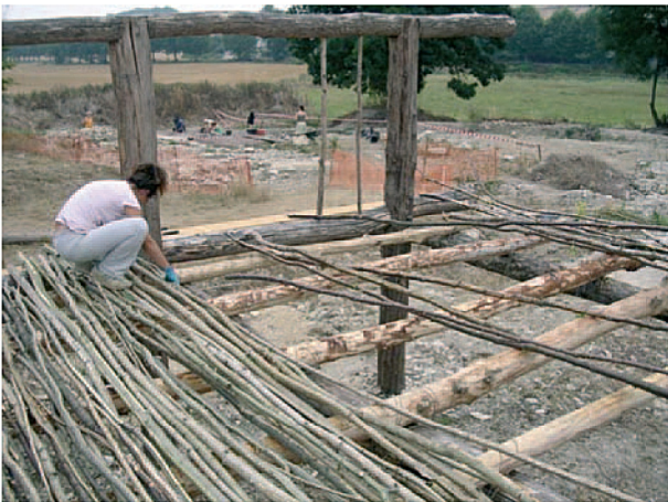
Fig. 25 - Pose des perches destinées au support de la couche de torchis du plancher.
