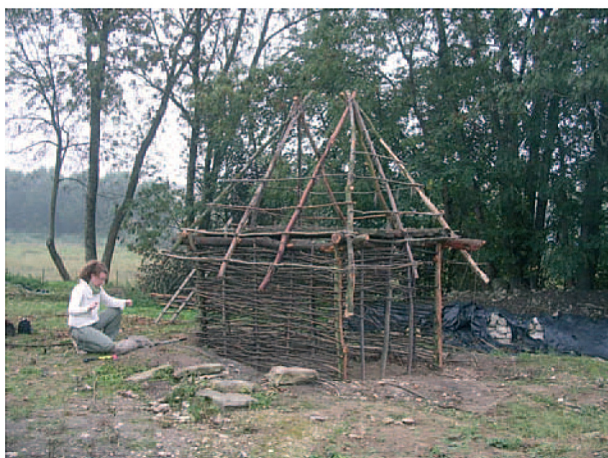
Fig. 12 - Les chevrons sont contreventés par le lattis de la couverture.
