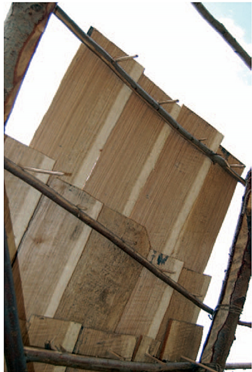
Fig. 38 - Fixation des bardeaux par des chevilles butant sur le lattis.
