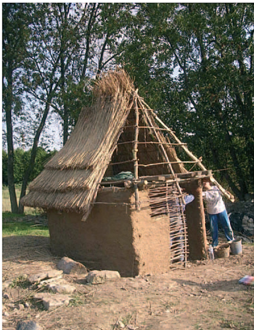
Fig. 16 - Vue de la pose de la couverture en espalier.
