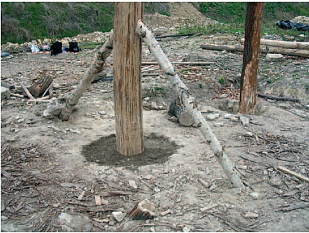
Fig. 23 - Calage provisoire des poteaux avec des pièces obliques plantés en terre.
