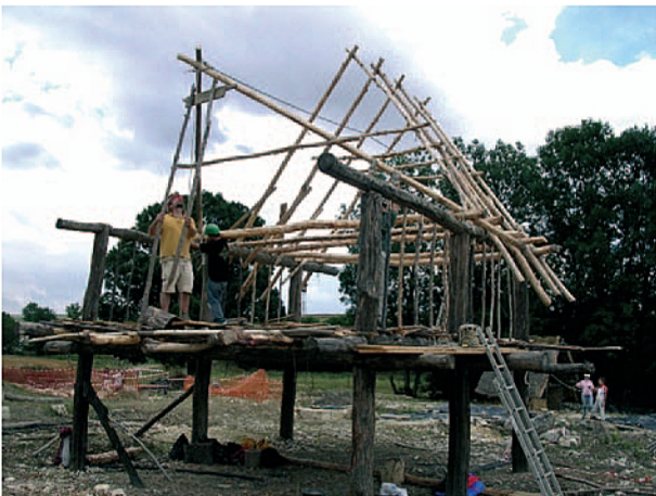
Fig. 31 - Levage de la charpente, ferme par ferme.
