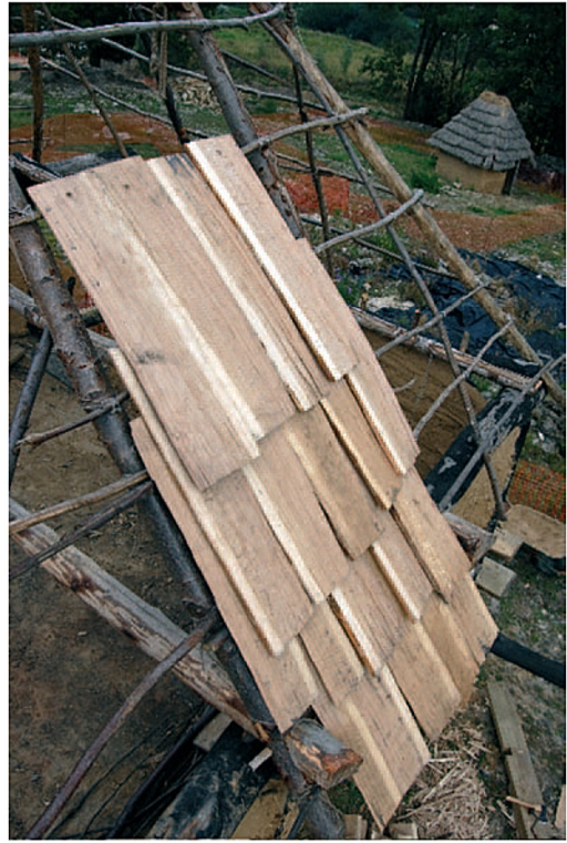
Fig. 37 - Pose de quelques bardeaux, avec un recouvrement de deux tiers.
