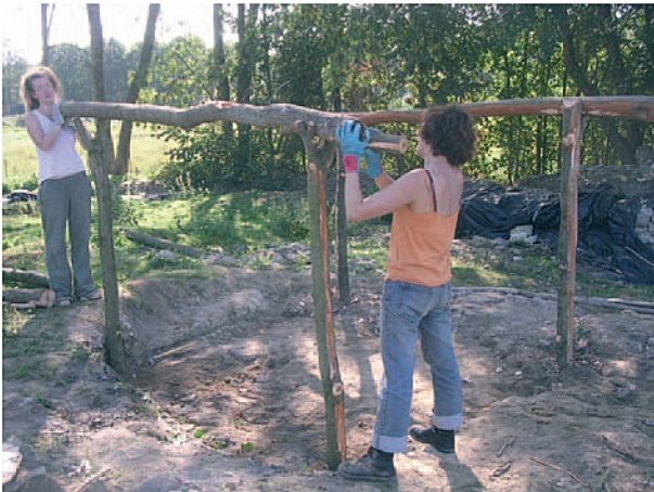
Fig. 7 - Pose des sablières dans les fourches des poteaux corniers.
