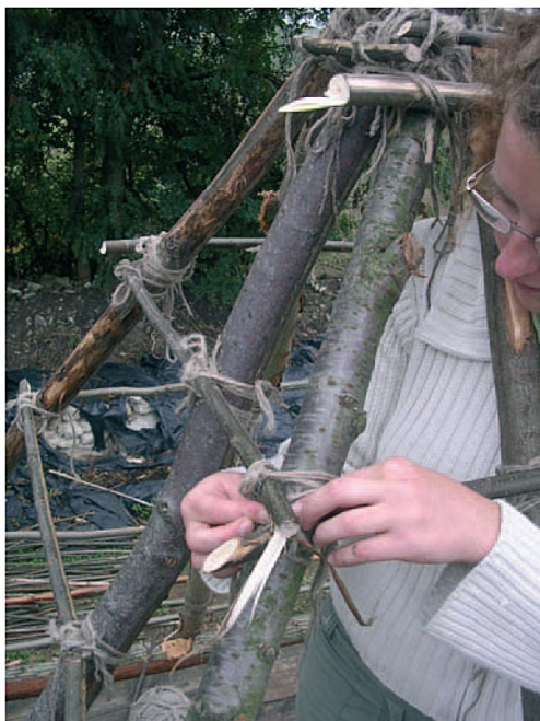
Fig. 11 - Fixation au fil de chanvre du lattis.
