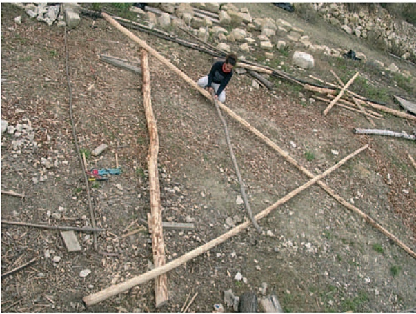
Fig. 27 - Réalisation au sol des fermes, aux bois assemblés à mi-bois chevillés.
