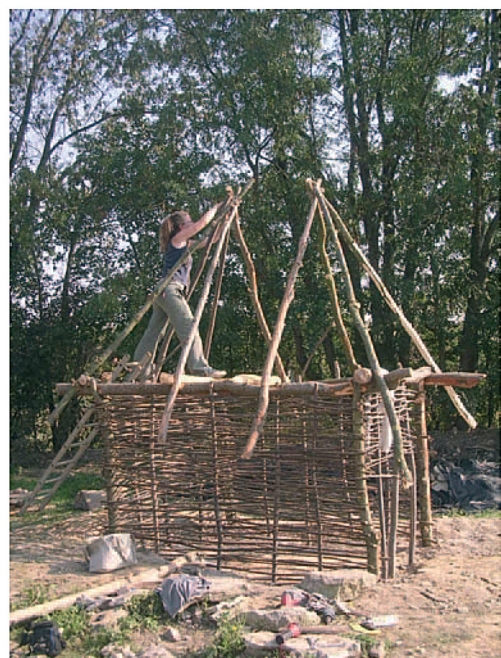
Fig. 10 - Pose des arêtiers de la croupe.
