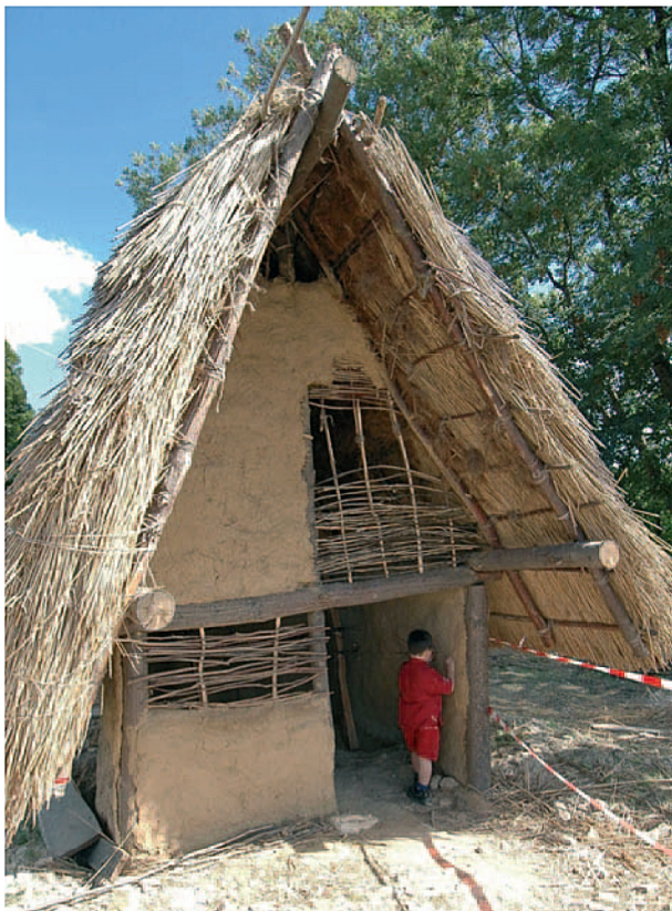
Fig. 2 - Vue de la reconstitution de la cabane en 2002 avec le pignon en torchis et clayonnage.
