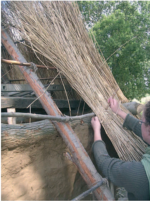
Fig. 14 - Pose des gerbes de roseaux, ligaturées au fil de chanvre.
