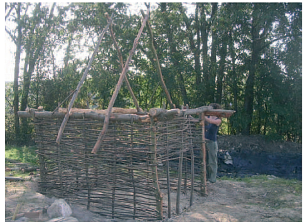
Fig. 9 - Vue de l'ossature et des deux fermes de la toiture, chevillées en pied dans la sablière.
