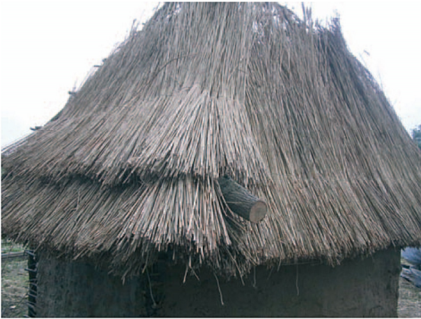
Fig. 15 - Disposition des gerbes en espalier.
