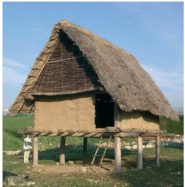
Fig. 33 - Pignon en clayonnage de la toiture à deux pans. encore à la charpente à poteaux faîtières, dépourvue de pièce transversale dans le comble.
