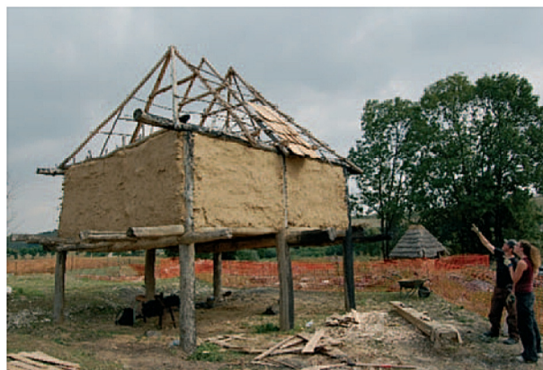
Fig. 35 - Nouvelle charpente du comble à quatre pans (2008).
