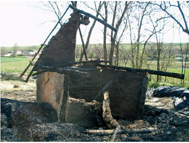
Fig. 3 - Destruction par incendie de la cabane en 2005.
