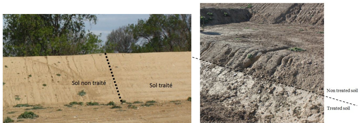
Figure 4 : vue du démonstrateur avant l'essai de surverse, 18 mois après la construction
