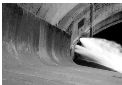
Barrage de Palisse ©BETCGB
