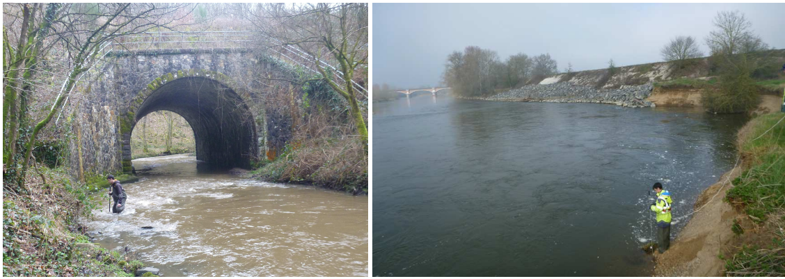
Figure 5. Deux sites 'pilotes' : (à gauche) pont ferroviaire sur l'Aurence, (à droite) remblai-digue le long de l'Allier.
