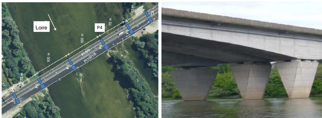
Figure 4. Site 'pilote' du double viaduc de l'A71 sur la Loire à Orléans, France : (à gauche) vue aérienne avec la position des piles, (à droite) vue latérale des piles P3.
