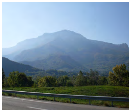
Figures 1 : Rocade Sud, Agglomération de Grenoble
