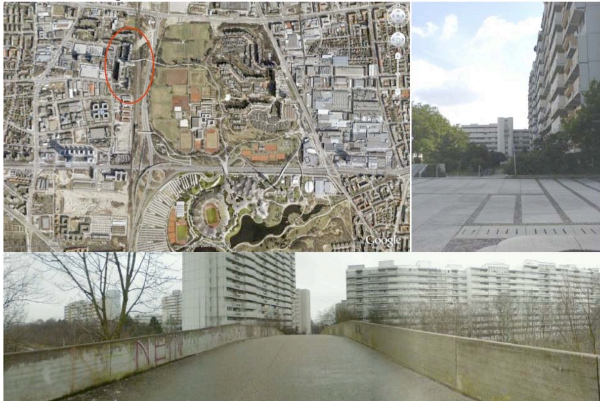
Olympia-Pressesstadt, Angerer & Branca, Neue Heimat (1969-72), chantier industrialisé.
