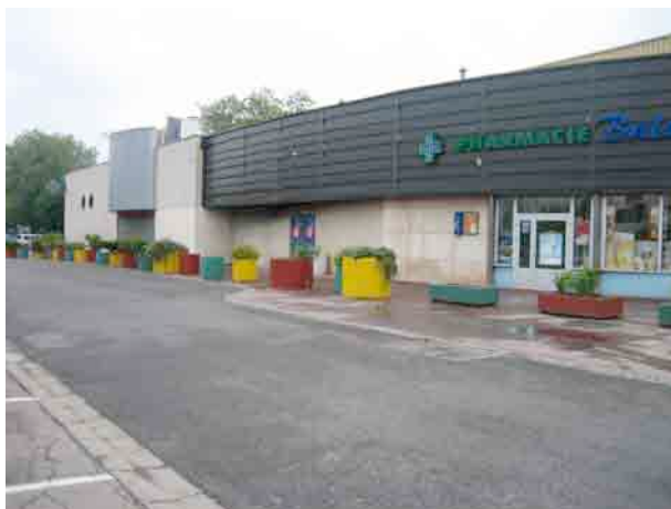
L'ancien supermarché, lieu de prière.
