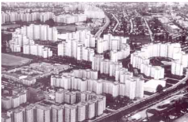
Vue d'ensemble, vue de Wilhelmsruher Damm.
