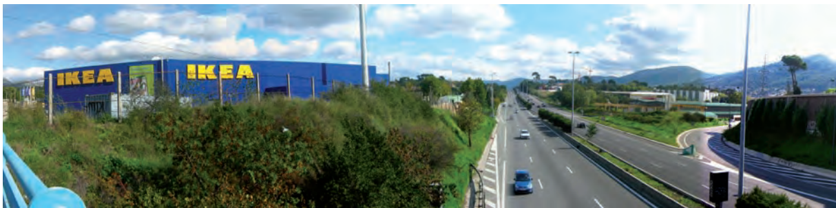
La vallée: un maillage de commerces, d'industries et de réseaux d'infrastructures.
