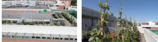
Figure 1. 200 jardinières et 500 m2 de surface potagère recouvre le toit de l'atrium, un bâtiment de cancérologie de la CP.
